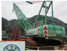
低騒音型建設機械の状況
