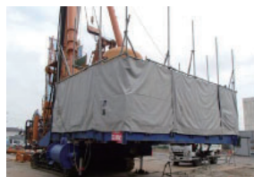
防音シートの設置の状況
