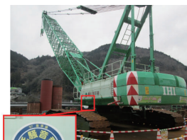
低騒音型建設機械の状況
