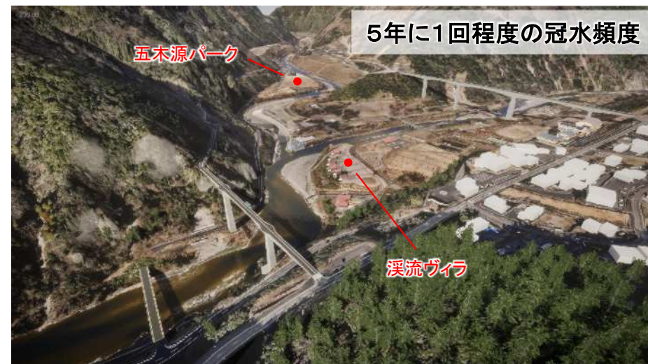
ダム操作の変更後
