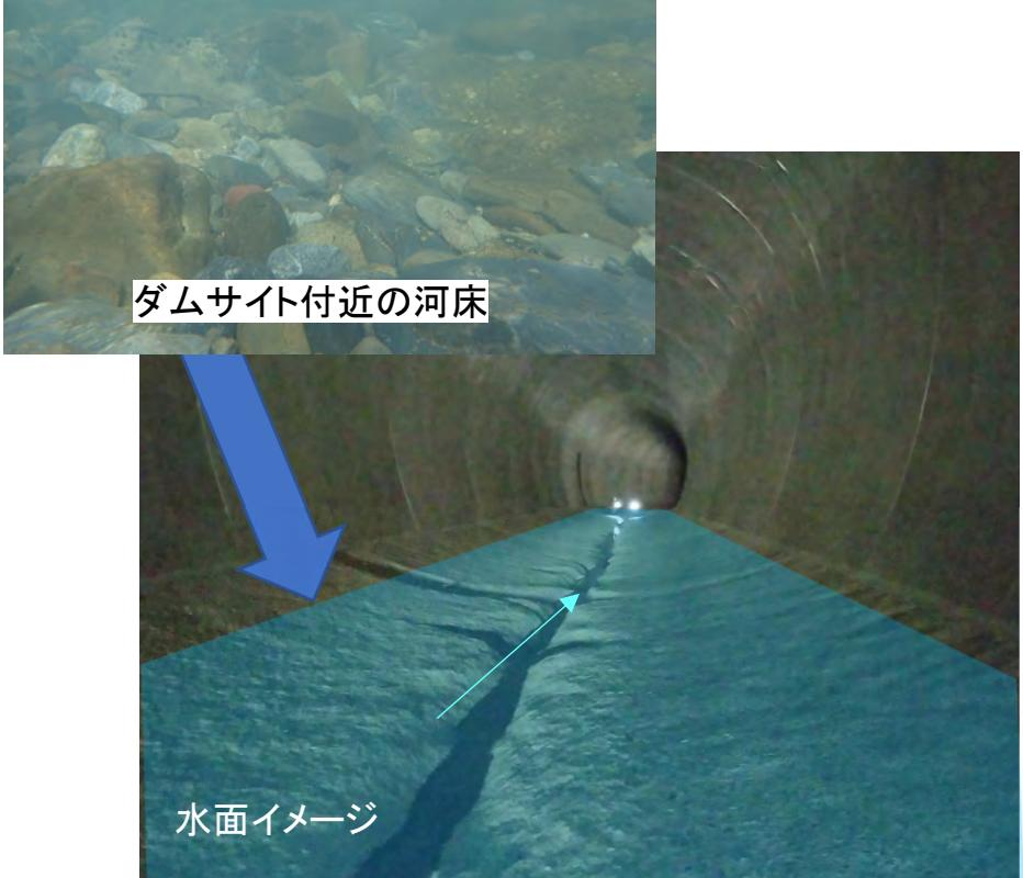
ダムサイト付近の河床環境を参考に、トンネル内部の河床を改良し、多様な河床環境を再現することで、生物の移動経路をできる限り確保する。
