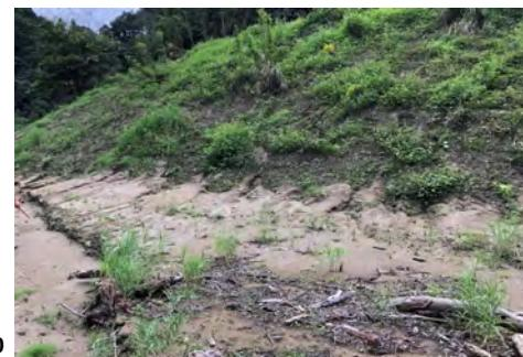
既往流水型ダム(辰巳ダム)の洪水調節後の堆積状況
