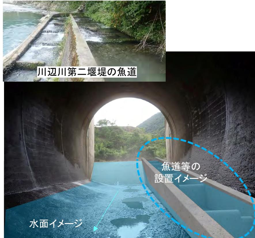
川辺川第二堰堤の魚道等を参考に、魚道等を設置し流速・勾配・水深条件を低減することで、生物の移動経路をできる限り確保する。
