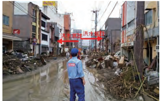
市街地の被災の様子（人吉市）
