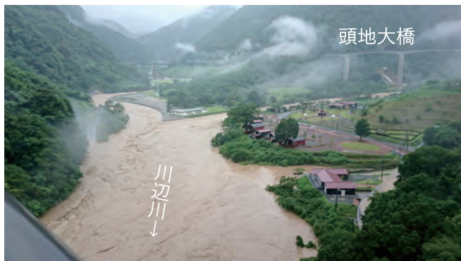
小八重橋より上流を望む（五木村）
