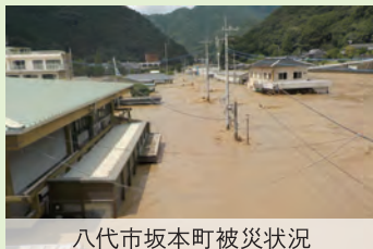
八代市坂本町被災状況
