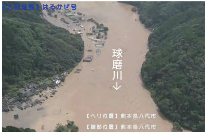
坂本支所周辺の浸水の様子（八代市坂本町）
