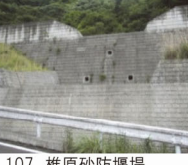
107. 椎原砂防堰堤 完成: 平成23年3月 堤高: 10.00m
