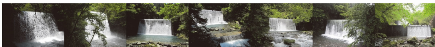
33. 空舎第2砂防堰堤 完成: 昭和49年3月 堤高: 12.00m
