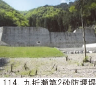
114. 九折瀬第2砂防堰堤 完成: 平成27年3月 堤高: 9.50m
