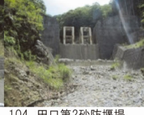
104. 田口第2砂防堰堤 完成: 平成20年3月 堤高: 11.50m
