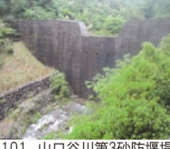
101. 山口谷川第3砂防堰堤 完成: 平成17年2月 堤高: 19.00m
