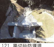
121. 築切砂防堰堤 完成: 令和4年3月 堤高: 9.50m
