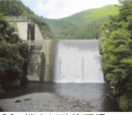
80. 樺木川砂防堰堤 完成: 平成6年2月 堤高: 20.00m
