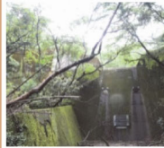
68. 高野川砂防堰堤 完成: 昭和62年3月 堤高: 10.00m
