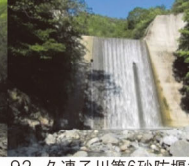
92. 久連子川第6砂防堰堤 完成: 平成8年2月 堤高: 20.00m
