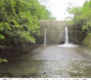
79. 板木川第4砂防堰堤 完成: 平成6年3月 堤高: 10.00m
