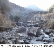
95. 椎葉谷川第3砂防堰堤 完成: 平成10年3月 堤高: 11.00m
