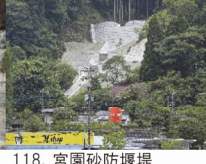
118. 宮園砂防堰堤 完成: 平成29年6月 堤高: 11.00m
