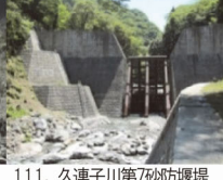
111. 久連子川第7砂防堰堤 完成: 平成25年7月 堤高: 14.50m
