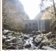
75. 折立川第3砂防堰堤 完成: 平成2年3月 堤高: 10.00m
