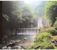
71. 葉木川第3砂防堰堤 完成: 昭和63年11月 堤高: 16.00m
