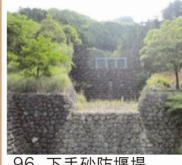
96. 下手砂防堰堤 完成: 平成10年9月 堤高: 14.50m
