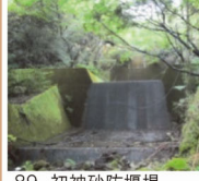
89. 初神砂防堰堤 完成: 平成6年10月 堤高: 13.50m
