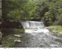
76. 栗鶴第3砂防堰堤 完成: 平成5年12月 堤高: 7.50m
