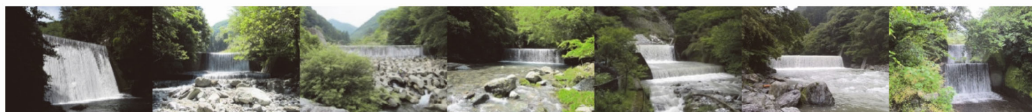
12. 登谷川砂防堰堤 完成: 昭和45年3月 堤高: 10.00m
