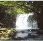
70. 下梶原川砂防堰堤 完成: 昭和63年3月 堤高: 9.00m
