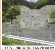
103. 椎原第2砂防堰堤 完成: 平成20年2月 堤高: 13.50m
