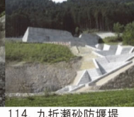
114. 九折瀬砂防堰堤 完成: 平成27年3月 堤高: 12.00m
