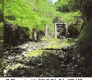
85. 内谷第5砂防堰堤 完成: 平成6年3月 堤高: 7.00m
