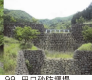
99. 田口砂防堰堤 完成: 平成14年5月 堤高: 14.50m
