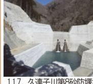
117. 久連子川第8砂防堰堤 完成: 平成29年3月 堤高: 14.50m
