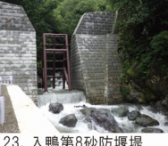
123. 入鴨第8砂防堰堤 完成: 令和7年6月 堤高: 14.50m
