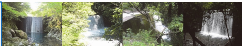
1. 飯干川第2砂防堰堤 完成: 昭和43年2月 堤高: 9.50m
