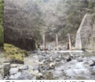
78. 下鶴第4砂防堰堤 完成: 平成5年12月 堤高: 7.50m
