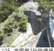
105. 宮園第2砂防堰堤 完成: 平成21年11月 堤高: 10.00m
