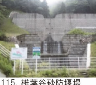
115. 椎葉谷砂防堰堤 完成: 平成27年7月 堤高: 14.00m
