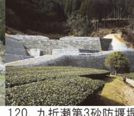
120. 九折瀬第3砂防堰堤 完成: 令和4年3月 堤高: 11.00m
