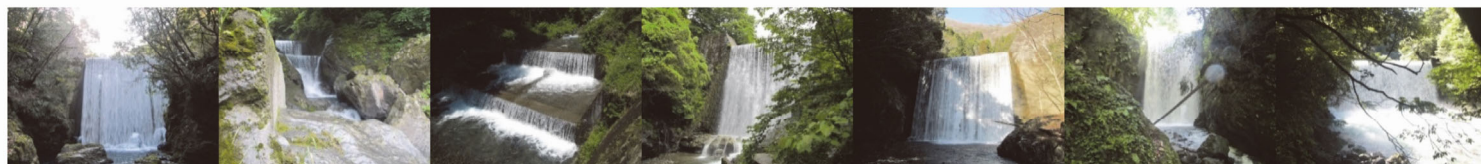
5. 平野川第3砂防堰堤 完成: 昭和43年10月 堤高: 12.50m
