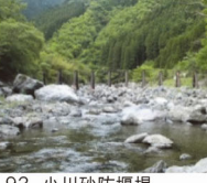
93. 小川砂防堰堤 完成: 平成8年3月 堤高: 8.00m
