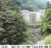
98. 桜谷川第2砂防堰堤 完成: 平成12年11月 堤高: 26.00m
