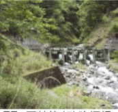
77. 栗鶴第4砂防堰堤 完成: 平成5年12月 堤高: 8.00m
