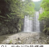
91. 谷内川砂防堰堤 完成: 平成7年8月 堤高: 23.50m
