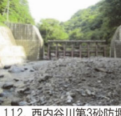
112. 西内谷川第3砂防堰堤 完成: 平成26年3月 堤高: 8.50m
