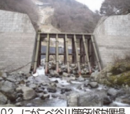
102. にかへ谷川第5砂防堰堤 完成: 平成19年1月 堤高: 11.00m
