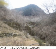
94. 内谷砂防堰堤 完成: 平成8年6月 堤高: 14.50m
