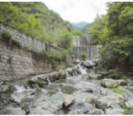
72. にかへ谷川第4砂防堰堤 完成: 平成元年2月 堤高: 15.50m
