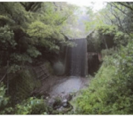
74. 晴山谷川第2砂防堰堤 完成: 平成元年10月 堤高: 13.50m
