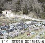
119. 高野川第2砂防堰堤 完成: 令和4年3月 堤高: 13.50m
