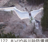
122. ホソコ谷川砂防堰堤 完成: 令和4年3月 堤高: 12.00m
