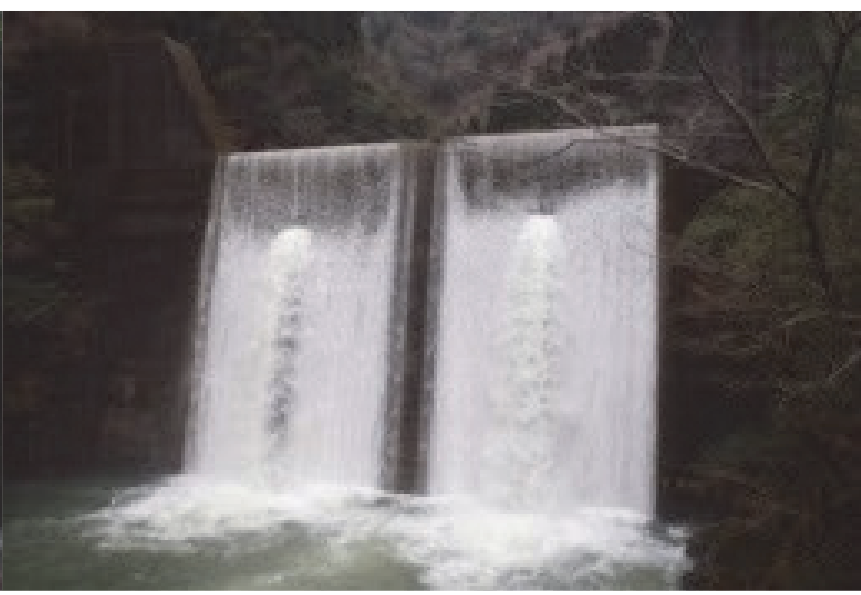
64. 小原川第2砂防堰堤 完成: 昭和60年11月 堤高: 21.00m
