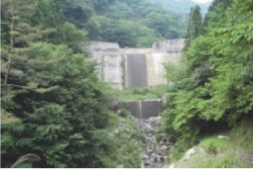
98. 桜谷川第2砂防堰堤 完成: 平成12年11月 堤高: 26.00m
