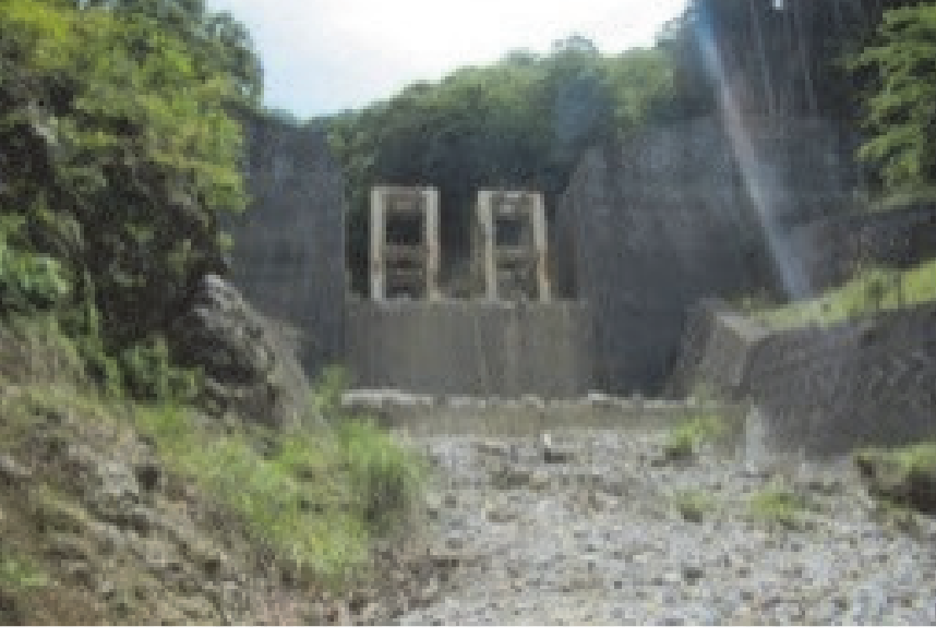
105. 田口第2砂防堰堤 完成: 平成20年3月 堤高: 11.50m
