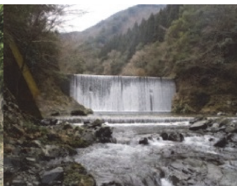
53. 竹の川第4砂防堰堤 完成：昭和55年9月 堤高：11.00m
