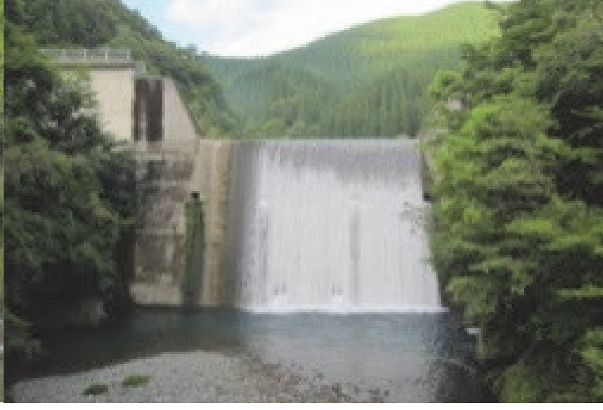
80. 縦木川砂防堰堤 完成: 平成6年2月 堤高: 20.00m
