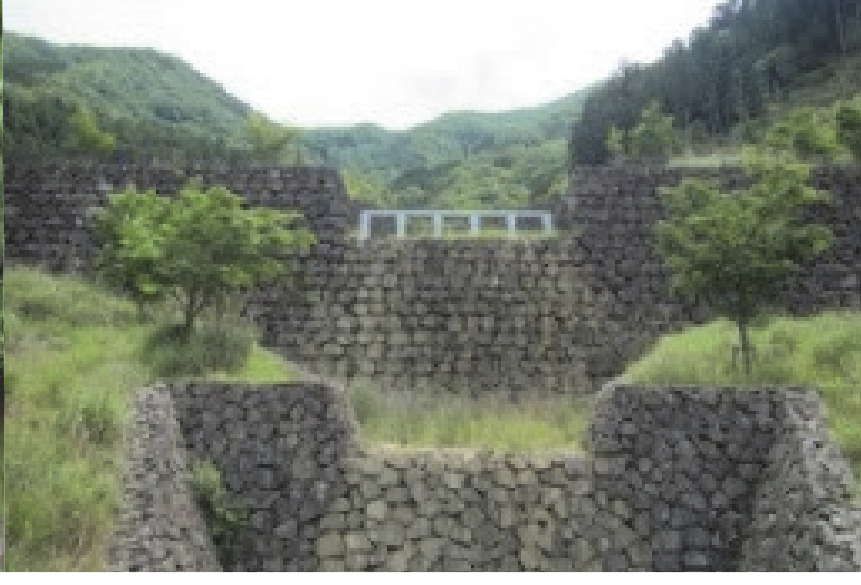
99. 田口砂防堰堤 完成: 平成13年1月 堤高: 14.50m
