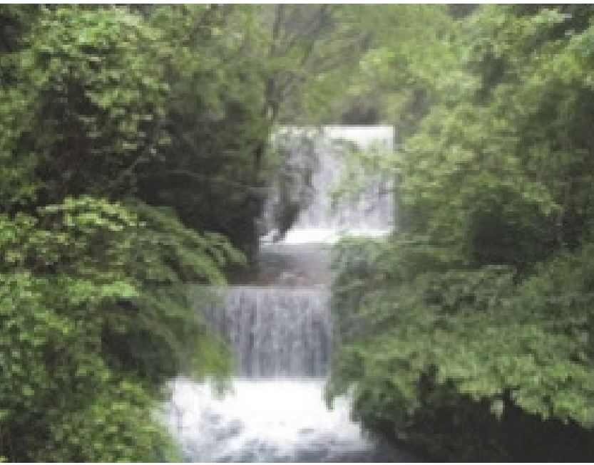
21. 山口谷川砂防堰堤 完成：昭和47年2月 堤高：10.00m
