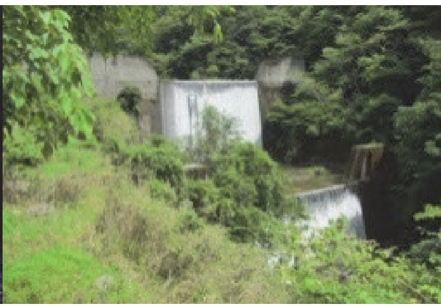
67. 板木川第3砂防堰堤 完成: 昭和61年10月 堤高: 20.00m
