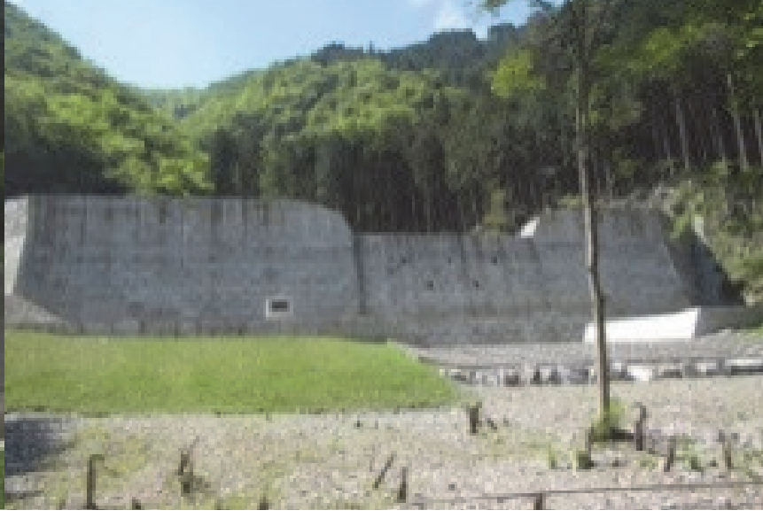
115. 九折瀬第2砂防堰堤 完成: 平成27年3月 堤高: 9.50m
