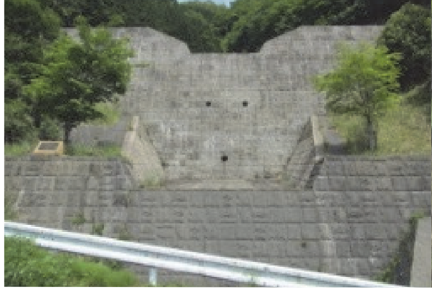
104. 椎原第2砂防堰堤 完成: 平成20年2月 堤高: 13.50m
