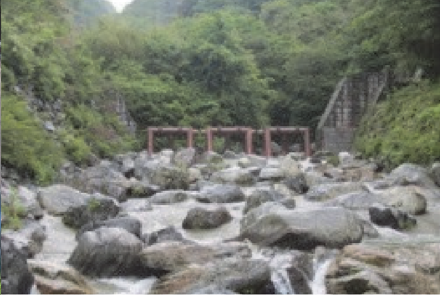
107. にかへ谷川第5砂防堰堤 完成: 平成21年12月 堤高: 6.00m
