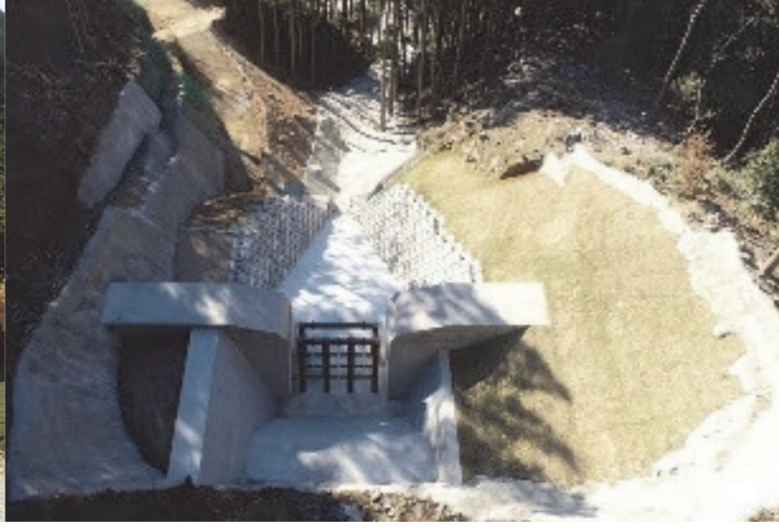
122. 築切砂防堰堤 完成: 令和4年3月 堤高: 6.50m
