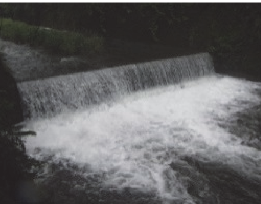
42. 山口谷川流路工 完成：昭和52年3月 延長：1340.00m
