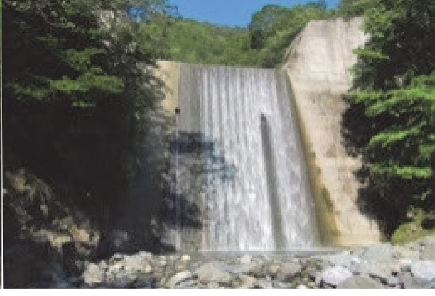
92. 久連子川第6砂防堰堤 完成: 平成8年2月 堤高: 20.00m
