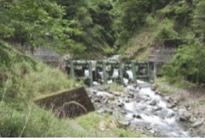
77. 栗鶴第4砂防堰堤 完成: 平成5年12月 堤高: 8.00m
