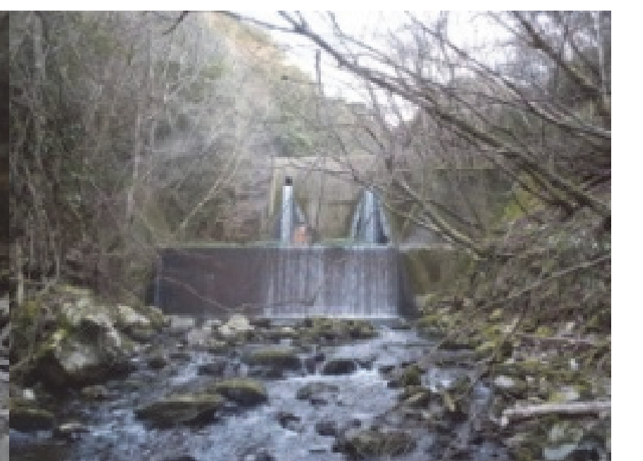
54. 藤田谷川砂防堰堤 完成：昭和55年11月 堤高：14.50m
