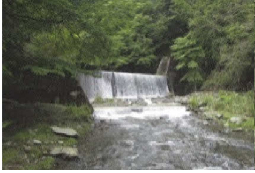
76. 栗鶴第3砂防堰堤 完成: 平成5年12月 堤高: 7.50m
