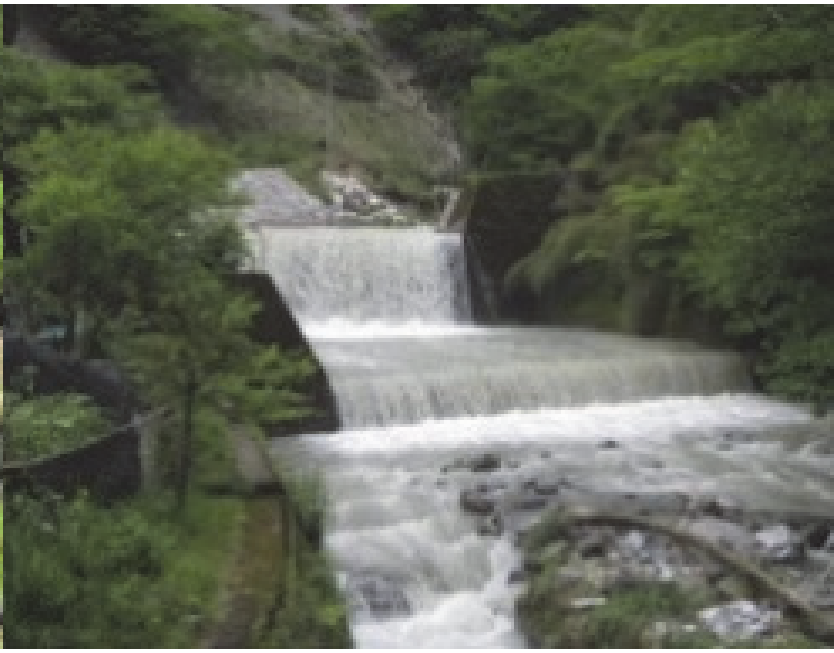
16. 入鴨川第4砂防堰堤 完成：昭和46年3月 堤高：8.00m
