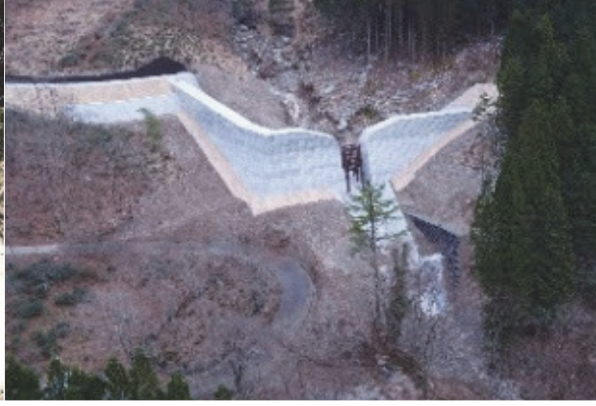
123. ホンコウ谷川砂防堰堤 完成: 令和4年3月 堤高: 8.50m
