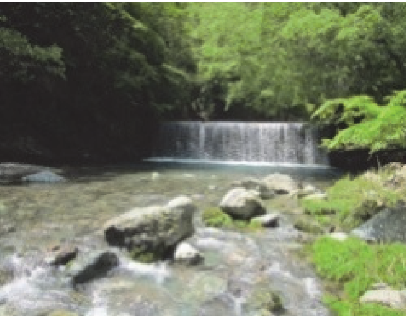
15. 中村砂防堰堤 完成：昭和46年1月 堤高：6.00m
