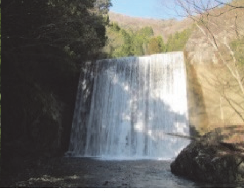
9. 入鴨川第3砂防堰堤 完成：昭和44年11月 堤高：17.00m
