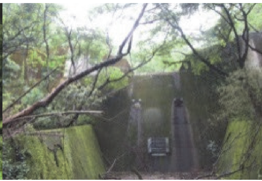
68. 高野川砂防堰堤 完成: 昭和62年3月 堤高: 10.00m
