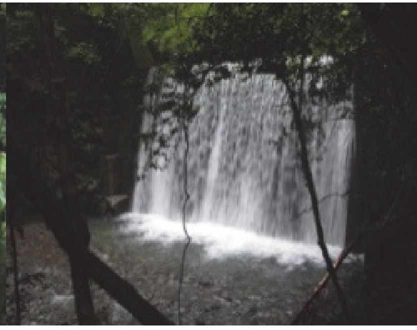
4. 折立川砂防堰堤 完成：昭和43年8月 堤高：12.00m
