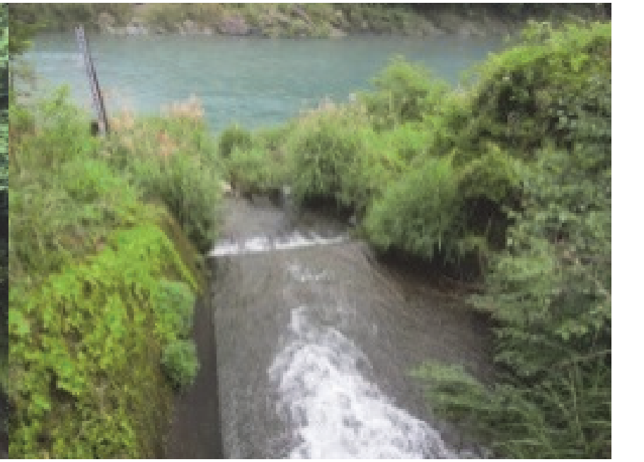
19. 大谷谷川流路工 完成：昭和46年3月 延長：150.00m
