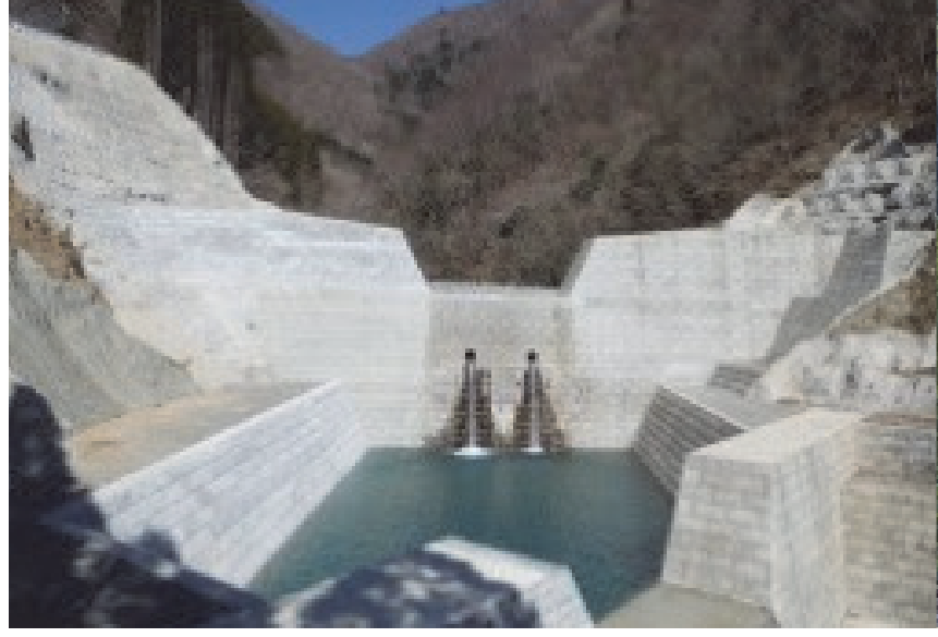
118. 久連子川第8砂防堰堤 完成: 平成29年3月 堤高: 14.50m
