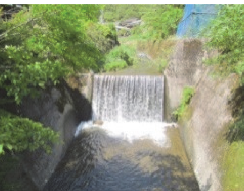
48. 平沢津流路工 完成：昭和53年12月 延長：245.50m
