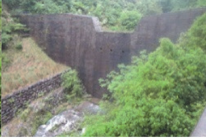
101. 山口谷川第3砂防堰堤 完成: 平成17年2月 堤高: 19.00m
