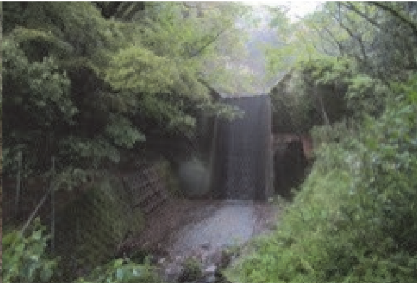
74. 晴山谷川第2砂防堰堤 完成: 平成元年10月 堤高: 13.50m
