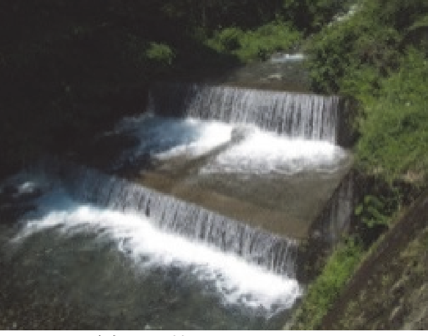
7. 栗鶴川階段工 完成：昭和44年3月 延長：218.90m
