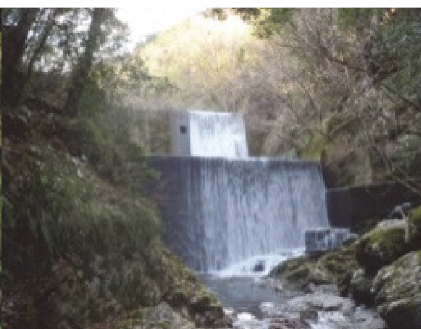
51. 椎葉谷川第2砂防堰堤 完成：昭和54年11月 堤高：13.00m
