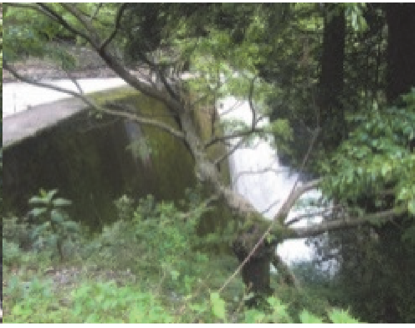
3. 入鴨川第2砂防堰堤 完成：昭和43年3月 堤高：12.00m
