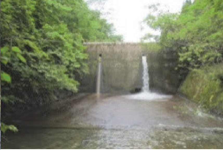
79. 板木川第4砂防堰堤 完成: 平成6年3月 堤高: 10.00m
