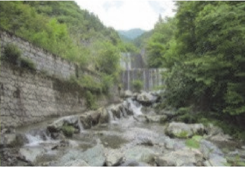
72. にかへ谷川第4砂防堰堤 完成: 平成元年2月 堤高: 15.50m
