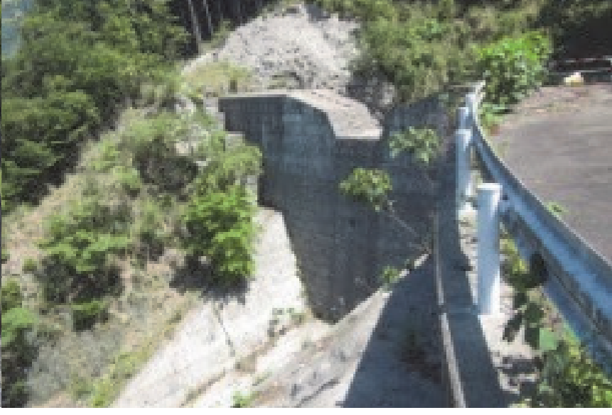
106. 宮園第2砂防堰堤 完成: 平成21年11月 堤高: 10.00m
