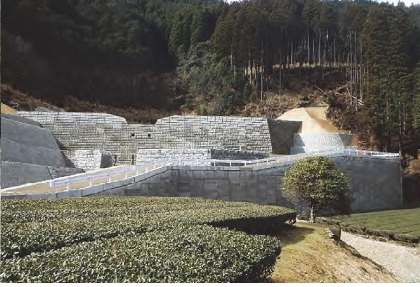
121. 九折瀬第3砂防堰堤 完成: 令和4年3月 堤高: 11.00m
