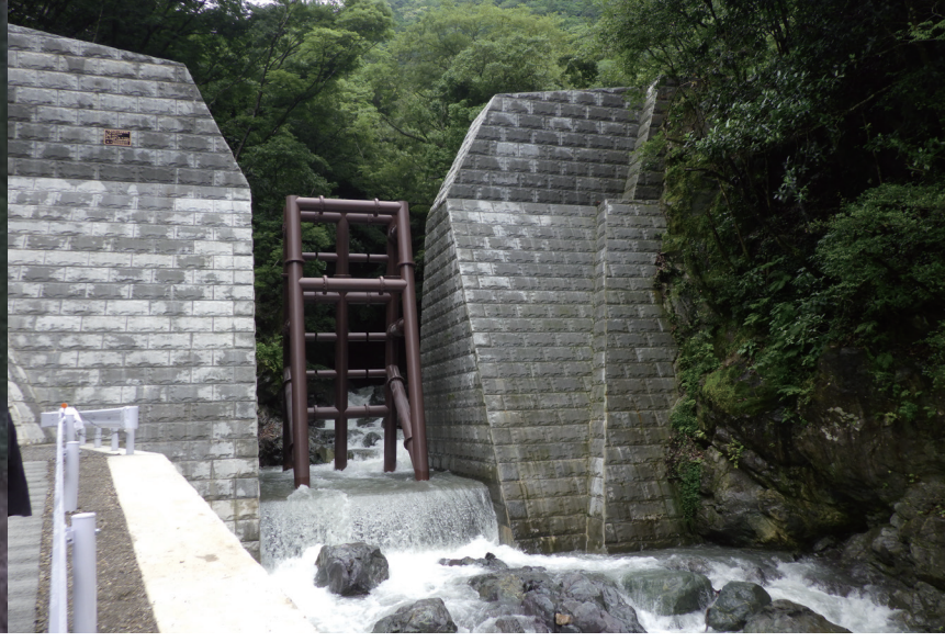
124. 入鴨川第8砂防堰堤 完成: 令和7年6月 堤高: 14.50m
