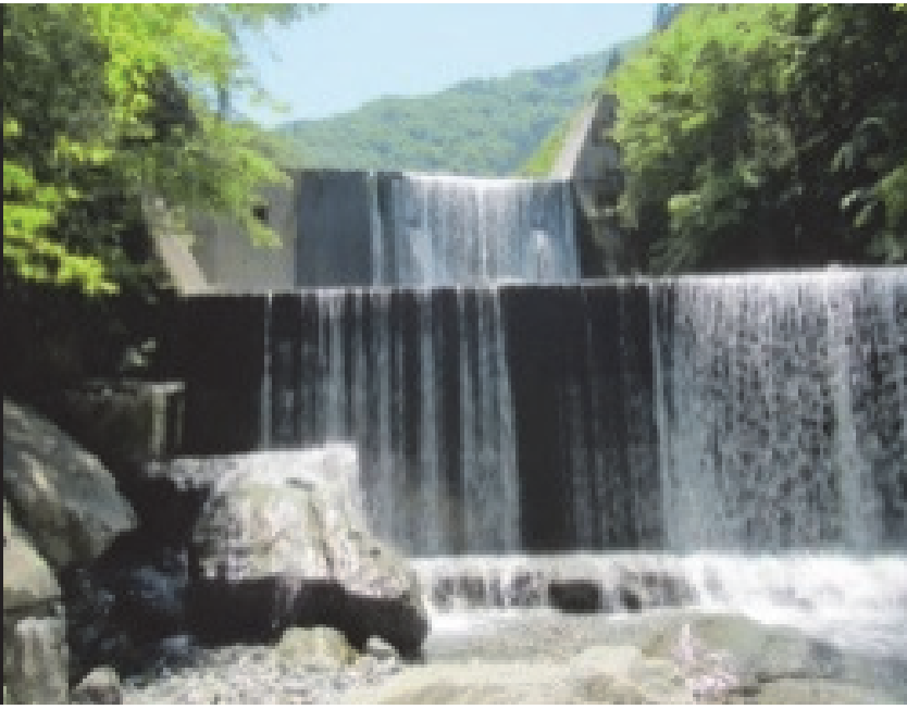
30. 久連子川第3砂防堰堤 完成：昭和49年3月 堤高：13.00m
