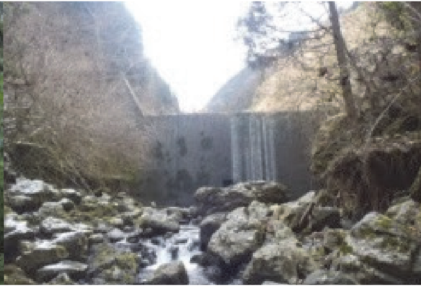
75. 折立川第3砂防堰堤 完成: 平成2年3月 堤高: 10.00m
