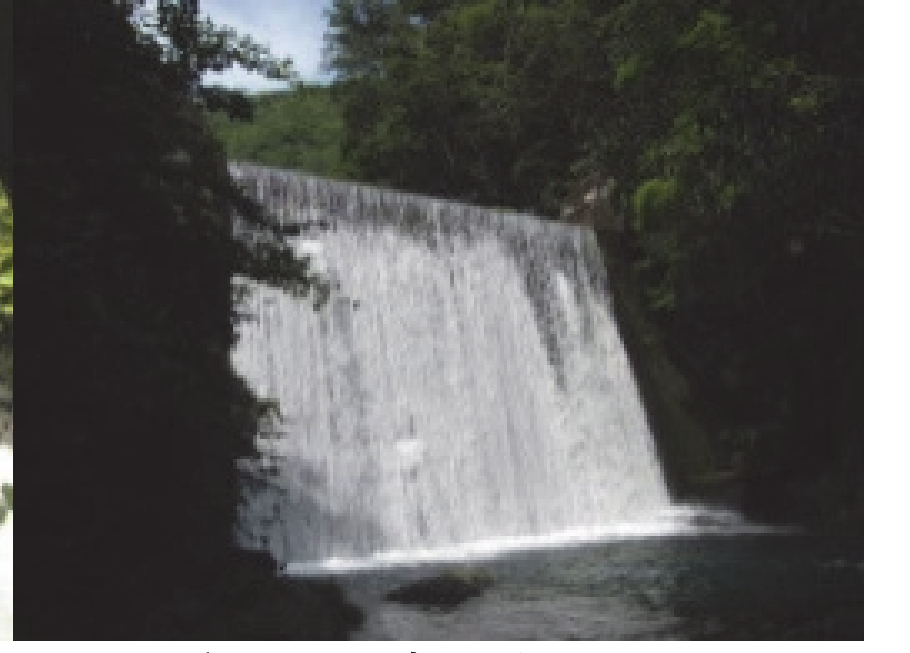
12. 登谷砂防堰堤 完成：昭和45年3月 堤高：10.00m
