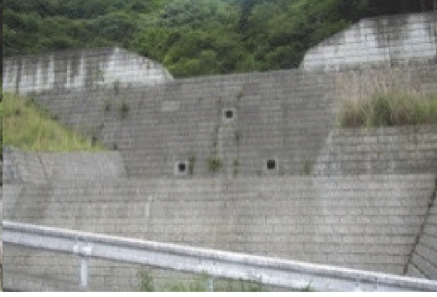
108. 椎原砂防堰堤 完成: 平成23年3月 堤高: 10.00m
