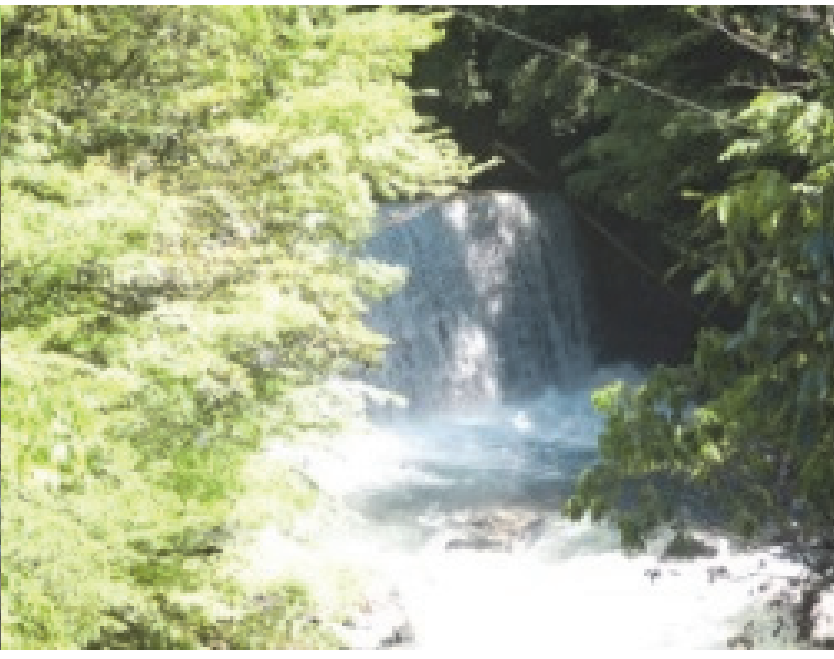
2. 竹の川第2砂防堰堤 完成：昭和43年3月 堤高：10.00m
