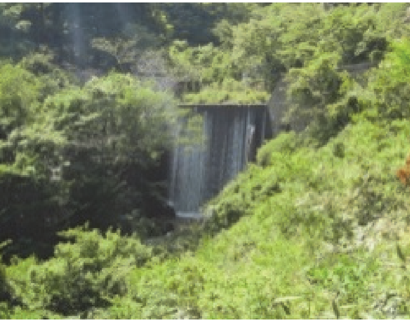
20. 平沢津砂防堰堤 完成：昭和46年3月 堤高：12.00m
