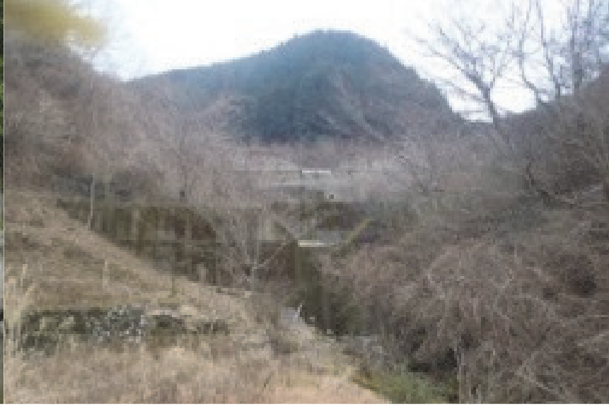
94. 内谷砂防堰堤 完成: 平成8年6月 堤高: 14.50m
