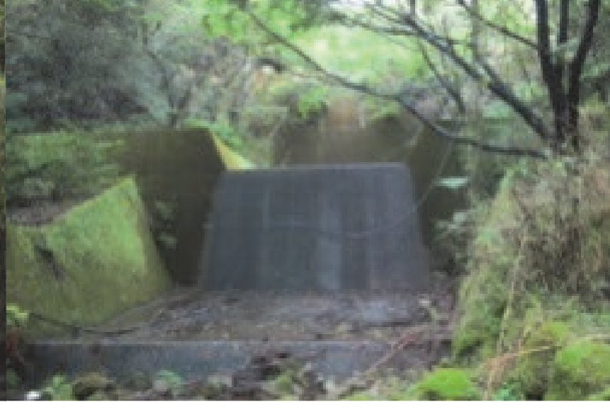
89. 初神砂防堰堤 完成: 平成6年10月 堤高: 13.50m
