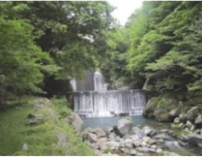
27. 小原砂防堰堤 完成：昭和48年3月 堤高：20.00m
