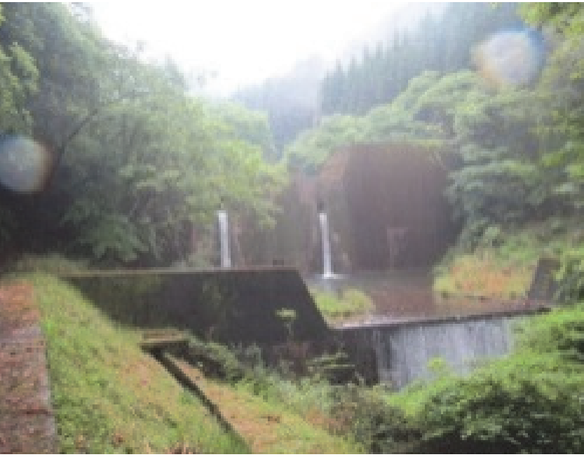
28. 晴山谷川砂防堰堤 完成：昭和48年8月 堤高：13.00m
