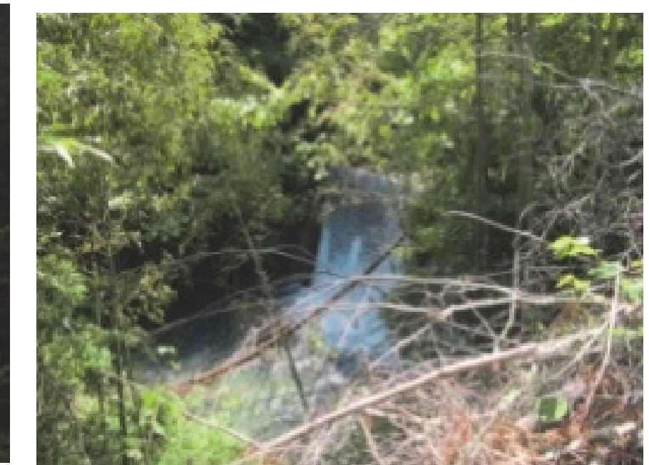
26. 椎葉砂防堰堤 完成：昭和48年2月 堤高：9.00m
