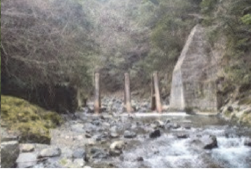
78. 下鶴第4砂防堰堤 完成: 平成5年12月 堤高: 7.50m
