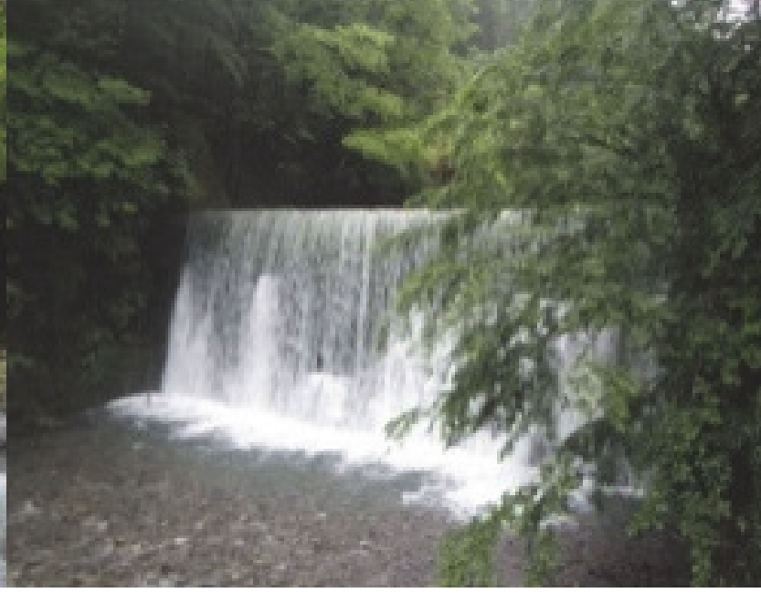
38. 折立川第2砂防堰堤 完成：昭和50年9月 堤高：10.00m
