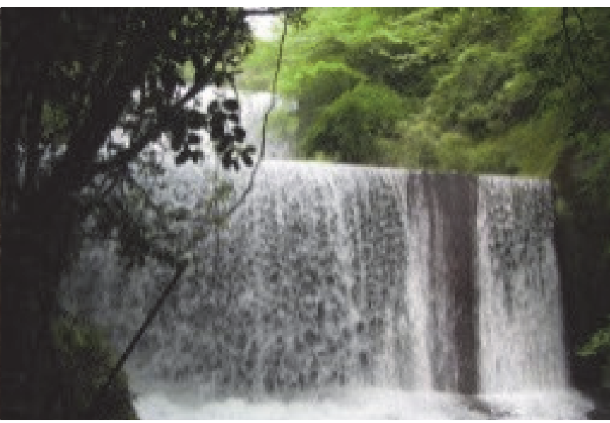
65. 入鴨川第7砂防堰堤 完成: 昭和61年3月 堤高: 14.00m
