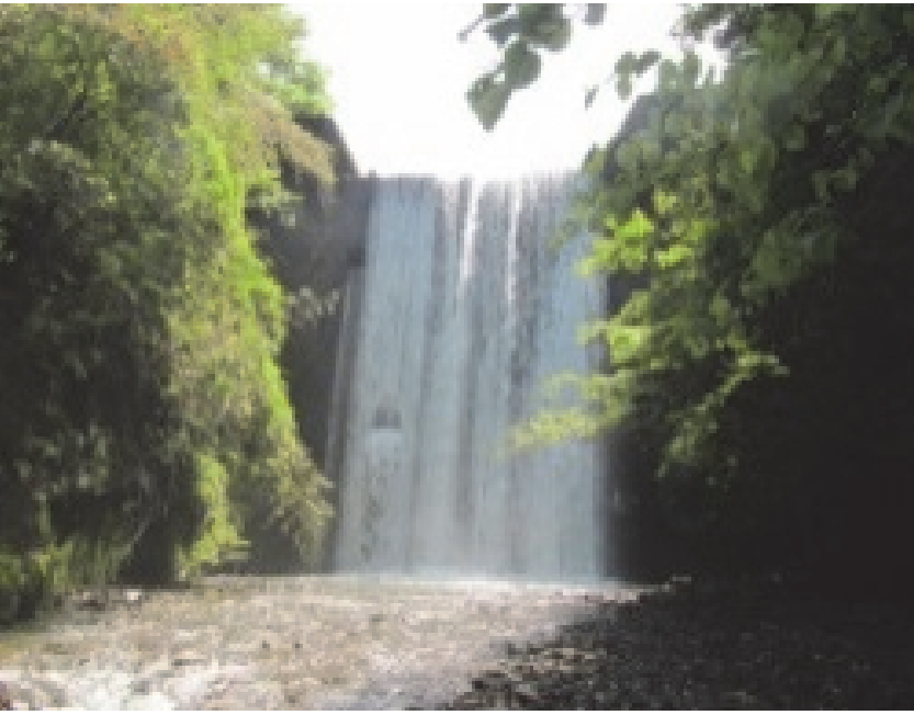
29. 鴛山川第2砂防堰堤 完成：昭和49年2月 堤高：20.00m
