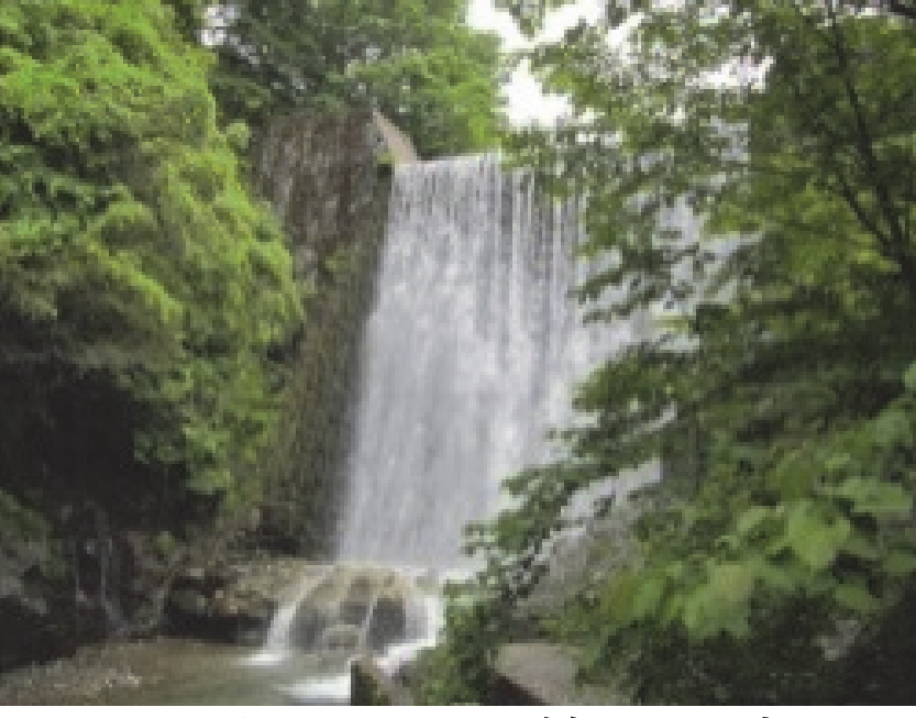
8. ながこべ谷川第2砂防堰堤 完成：昭和44年10月 堤高：15.00m
