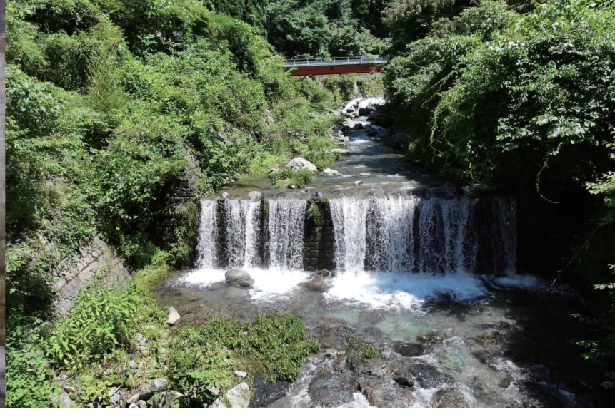
103. 山の津谷川渓流保全工 完成: 平成19年3月 延長: 252.60m
