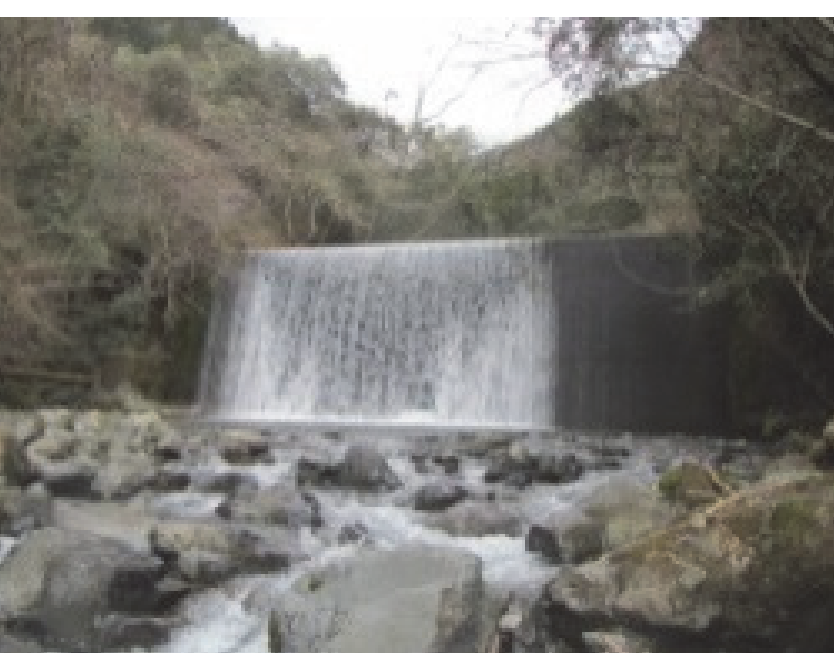
55. 椎葉谷川砂防堰堤 完成：昭和55年3月 堤高：8.00m
