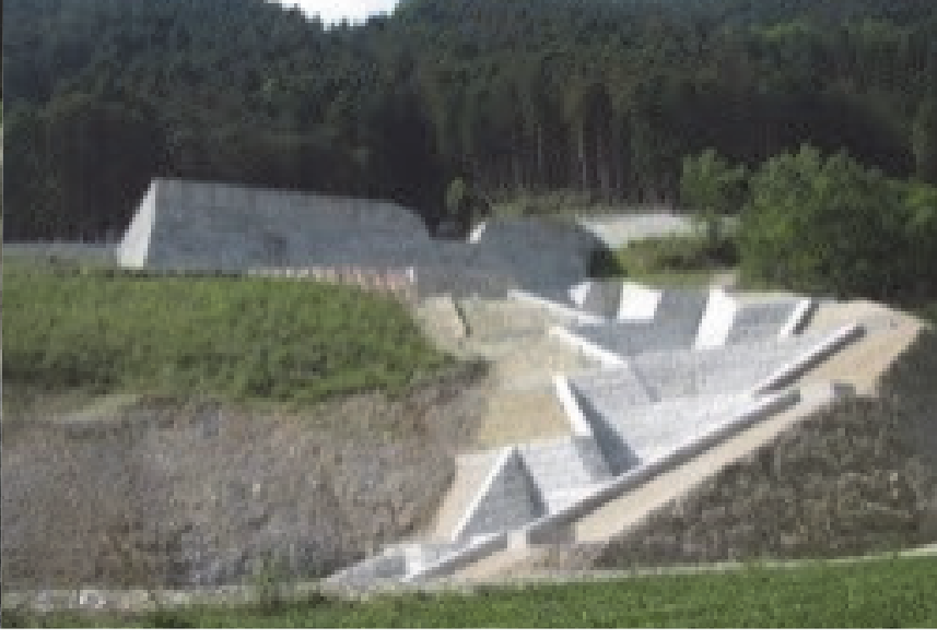
114. 九折瀬砂防堰堤 完成: 平成27年3月 堤高: 12.00m
