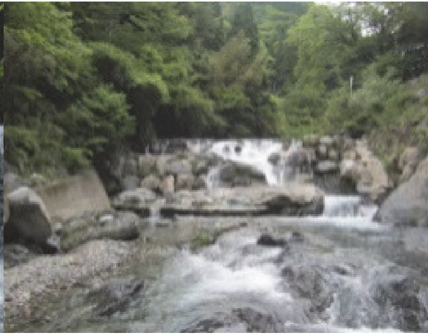
31. ながこべ谷川第3砂防堰堤 完成：昭和49年3月 堤高：6.50m
