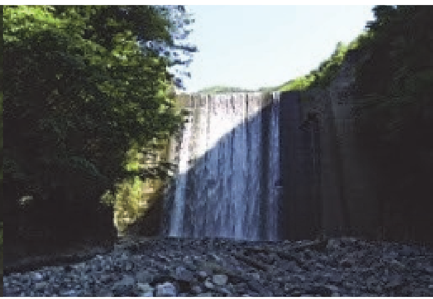
66. 久連子川第5砂防堰堤 完成: 昭和61年5月 堤高: 22.00m
