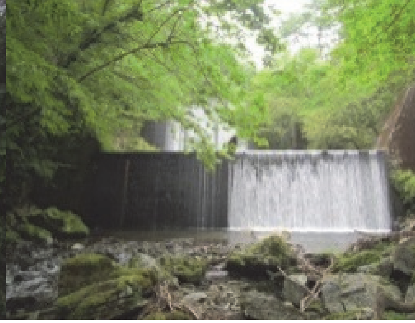
39. 腰越砂防堰堤 完成：昭和50年9月 堤高：15.00m
