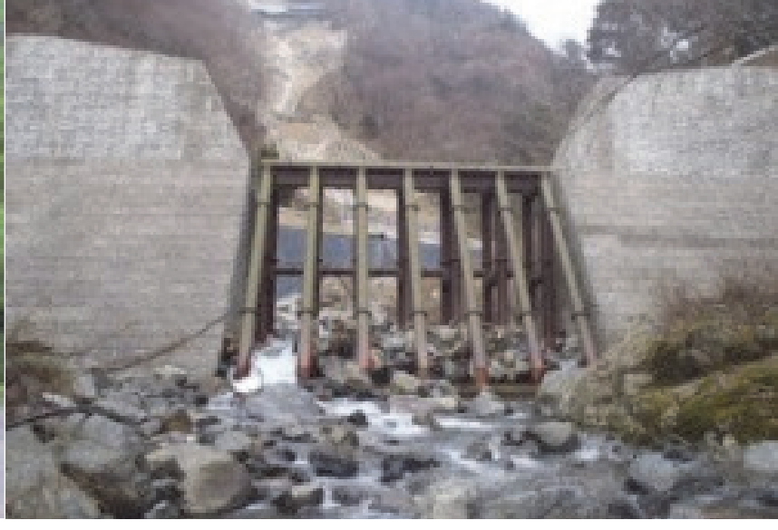
102. にかへ谷川第6砂防堰堤 完成: 平成19年1月 堤高: 11.00m
