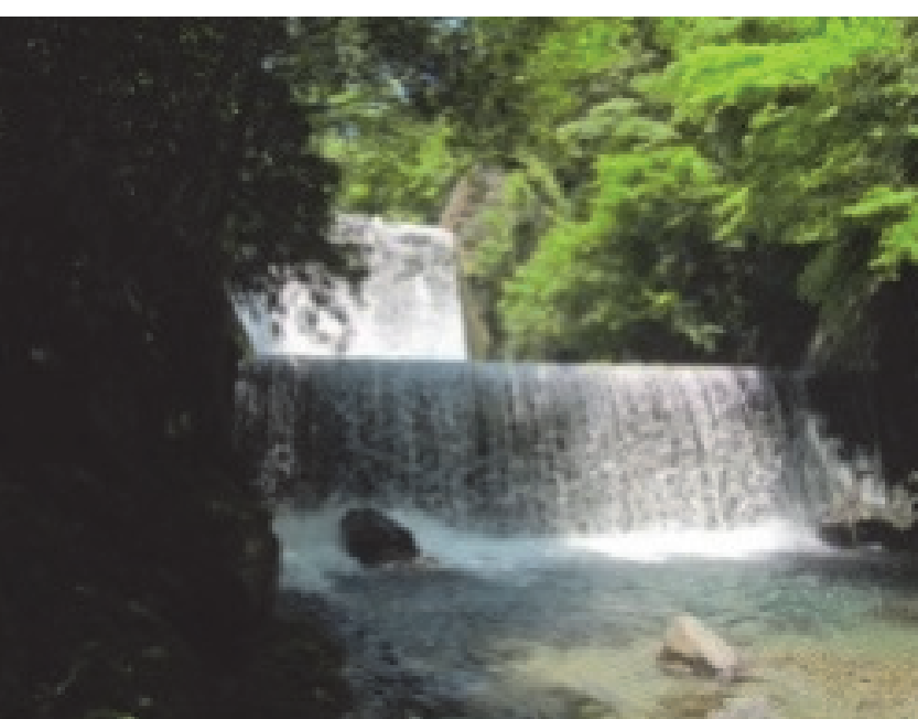
49. 下鶴第2砂防堰堤 完成：昭和54年2月 堤高：15.50m
