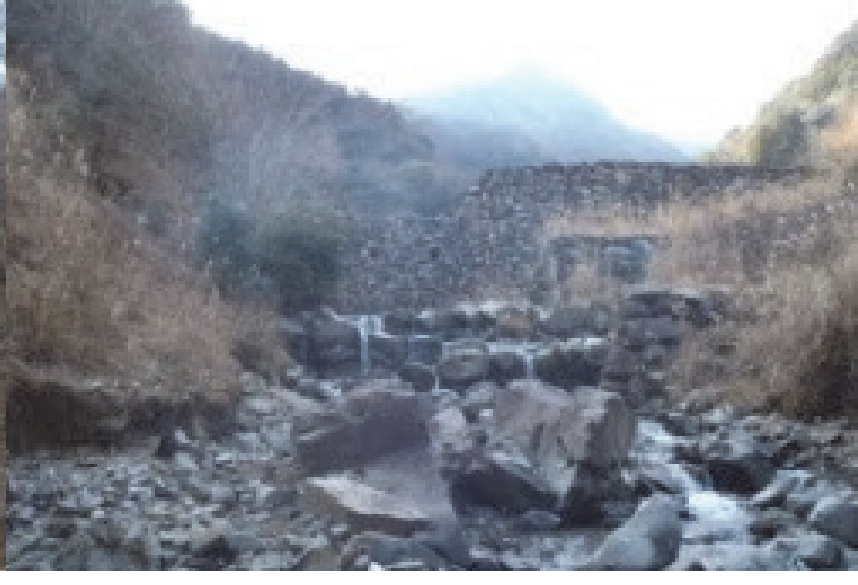
95. 椎葉谷川第3砂防堰堤 完成: 平成10年3月 堤高: 11.00m
