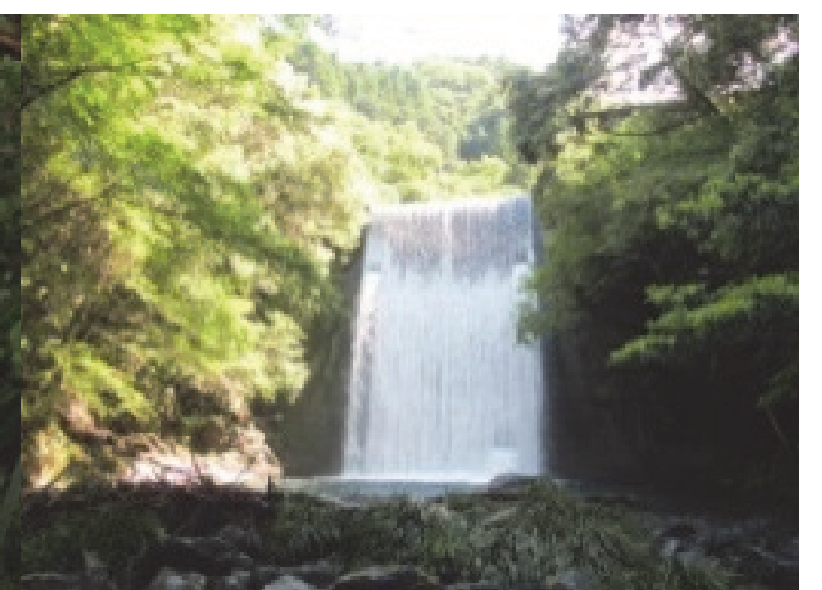
61. 宮目木川砂防堰堤 完成：昭和58年6月 堤高：18.50m
