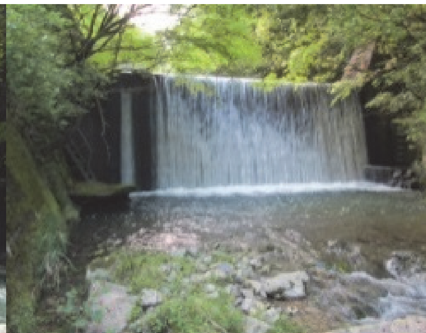
46. 登谷川第3砂防堰堤 完成：昭和53年3月 堤高：7.50m
