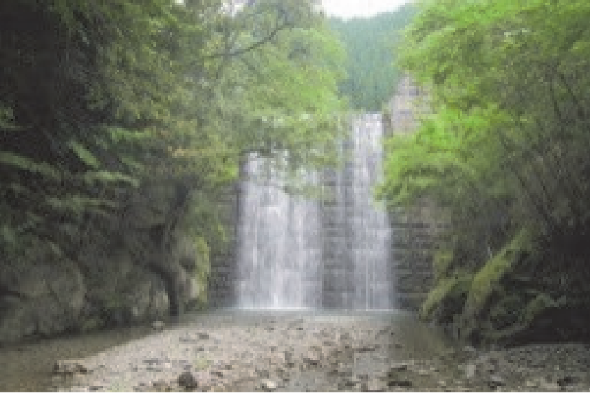
91. 谷内川砂防堰堤 完成: 平成7年8月 堤高: 23.50m
