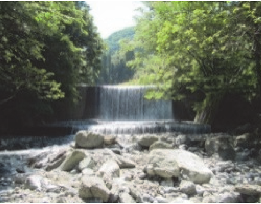
13. 久連子川第2砂防堰堤 完成：昭和45年9月 堤高：10.00m
