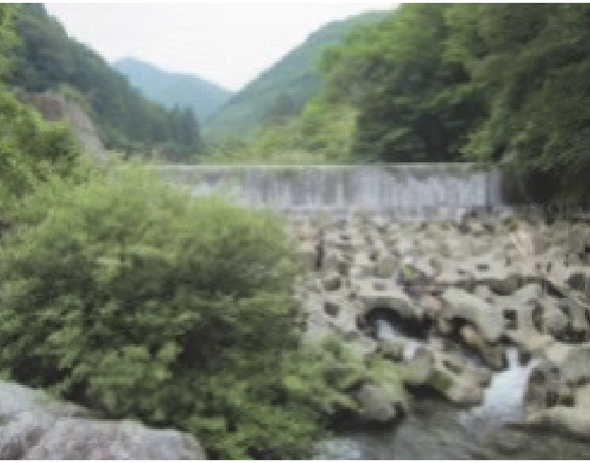
14. 葉木川第2砂防堰堤 完成：昭和45年11月 堤高：6.00m
