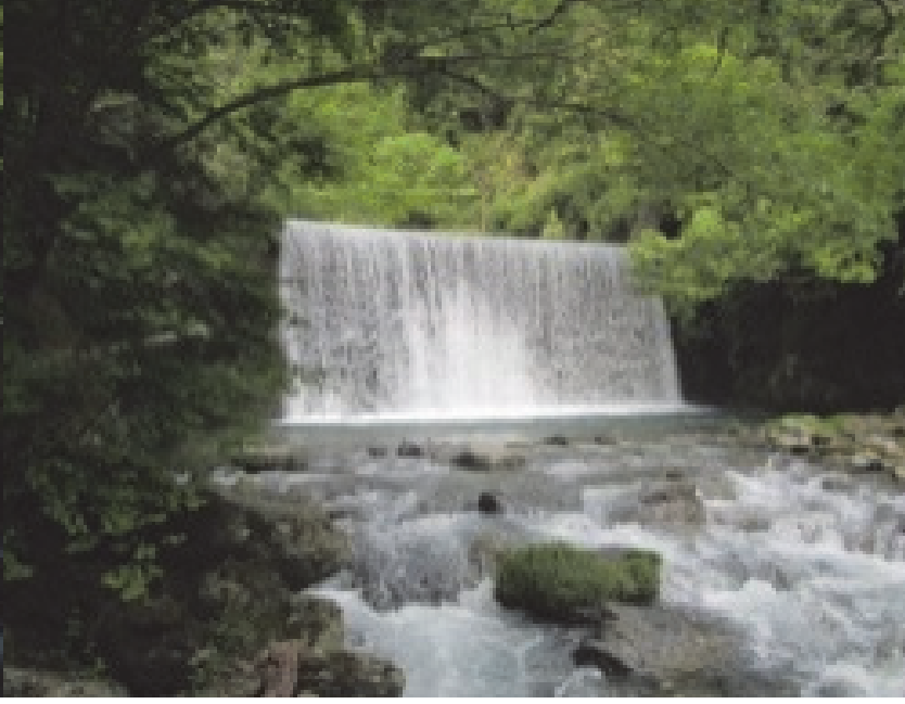
37. 板木川第2砂防堰堤 完成：昭和50年3月 堤高：10.00m
