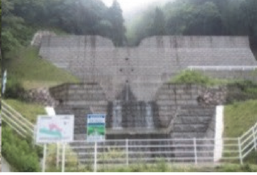
116. 椎葉谷砂防堰堤 完成: 平成27年7月 堤高: 14.00m
