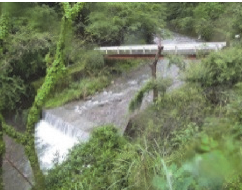
43. 折立川流路工 完成：昭和52年3月 延長：259.50m
