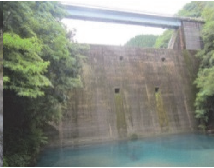
32. 樺木砂防堰堤 完成：昭和49年3月 堤高：30.00m
