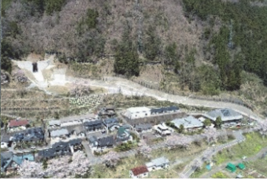
120. 高野川第2砂防堰堤 完成: 令和4年3月 堤高: 13.50m
