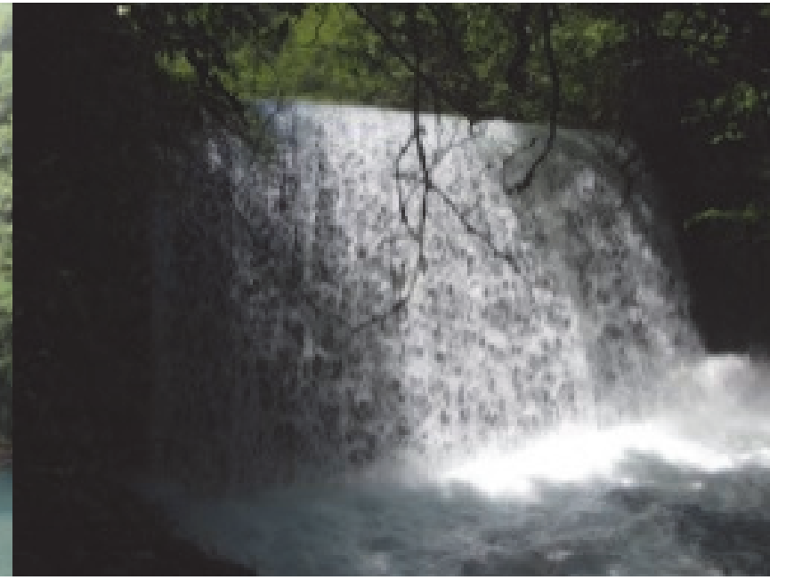
33. 空舎第2砂防堰堤 完成：昭和49年3月 堤高：12.00m
