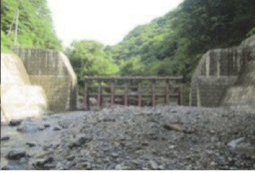
113. 西内谷川第3砂防堰堤 完成: 平成26年3月 堤高: 8.50m
