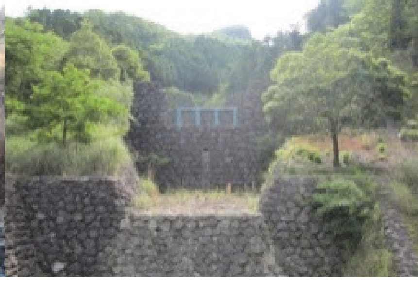
96. 下手砂防堰堤 完成: 平成10年9月 堤高: 14.50m
