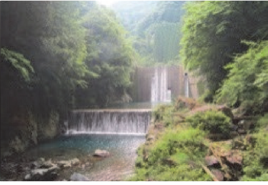
71. 葉木川第3砂防堰堤 完成: 昭和63年11月 堤高: 16.00m
