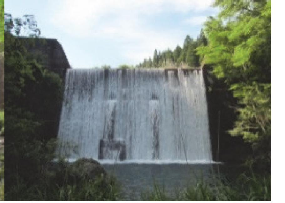
40. 登谷川第2砂防堰堤 完成：昭和51年3月 堤高：10.50m
