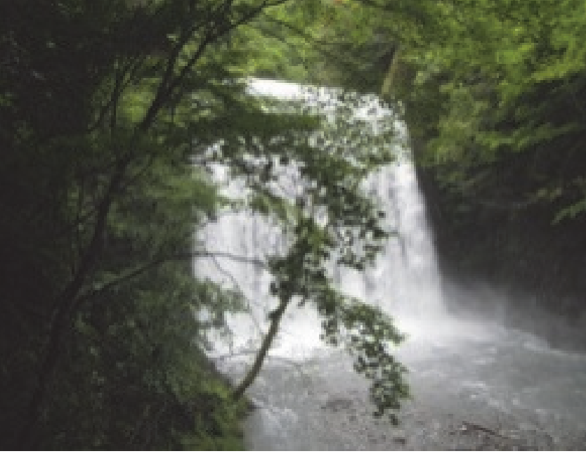
34. 入鴨川第5砂防堰堤 完成：昭和49年7月 堤高：20.00m
