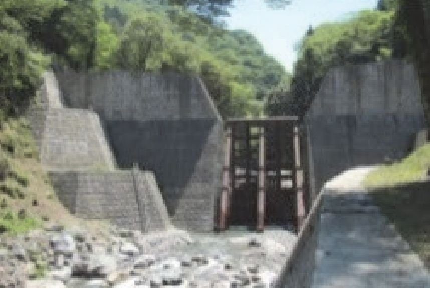
112. 久連子川第7砂防堰堤 完成: 平成25年7月 堤高: 14.50m
