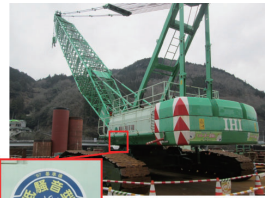
低騒音型建設機械の状況
