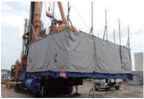
防音シートの設置の状況
