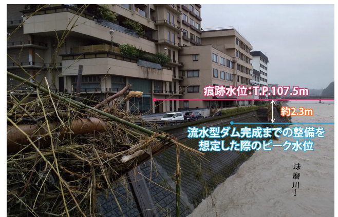
球磨川人吉市街部（球磨川61k600付近）の 水位低減効果
