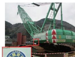
低騒音型建設機械の状況
