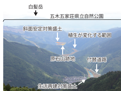
(試験湛水直後)
