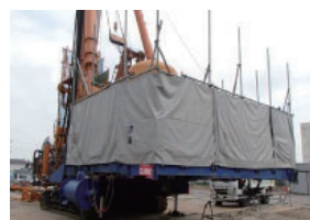
防音シートの設置の状況
