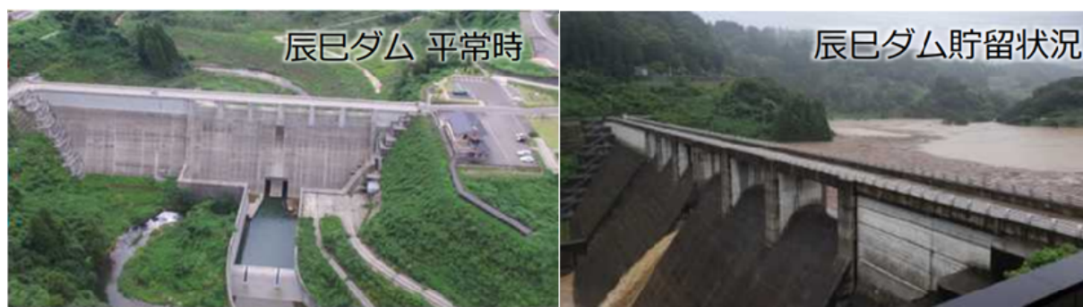
図 2-6 既往流水型ダム（辰巳ダム）の平常時（左）と洪水調節時（右）の写真
