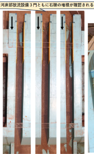
⑤ 通水後 河床部放流設備内
