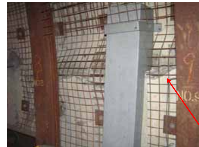
コンクリート剥落部の計測
