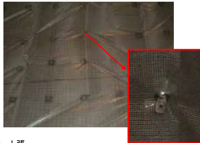
②ビニールシート設置状況
