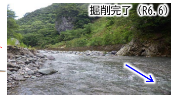
<梶原川改良掘削状況>
