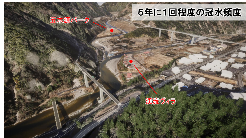
ダム操作の変更後
