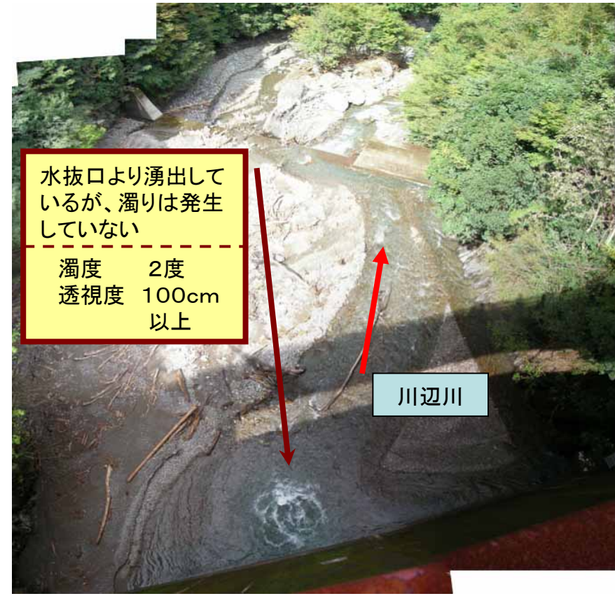
⑦ 樅木砂防えん堤直下流
