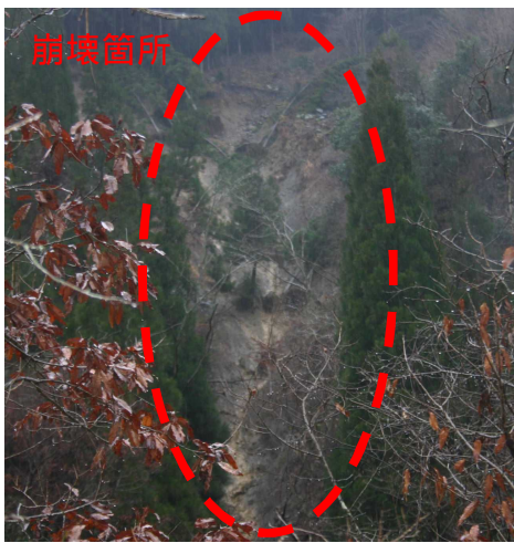
山腹崩壊状況
