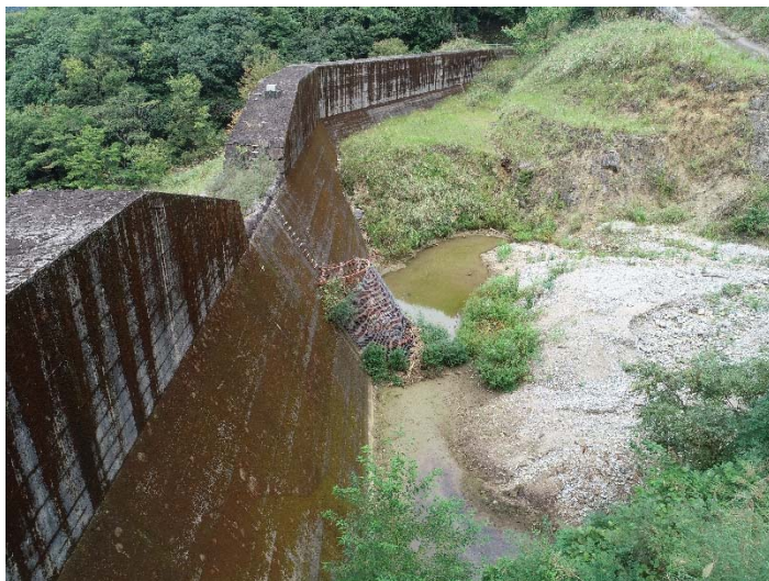
田口第2砂防堰堤(堰堤高11.5 m、堰堤長57.0m)
