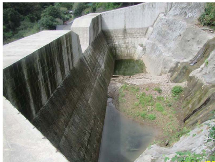
椎葉谷第2砂防堰堤(堰堤高14.5 m、堰堤長83.0m)
