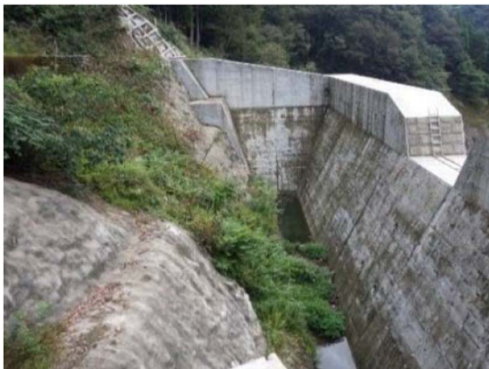
椎葉谷第2砂防堰堤(堰堤高14.5 m、堰堤長83.0m)
