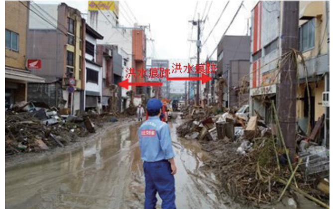
市街地の被災の様子 (人吉市)
