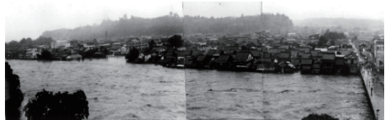
人吉大橋付近の人吉市街部浸水状況(人吉市)
