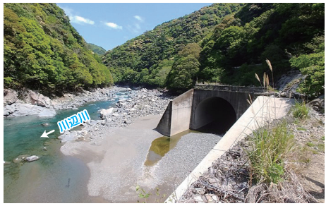
① 仮排水路トンネル(吐口)
