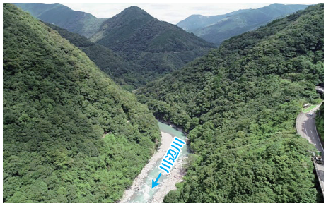
② ダムサイトの状況
