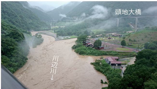
小八重橋より上流を望む (五木村)
