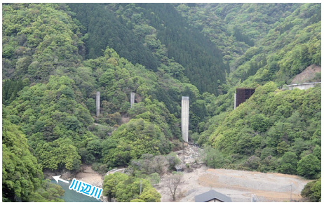
③ 付替村道ダムサイト～頭地線(逆瀬川1号橋)
