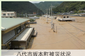
八代市坂本町被災状況
