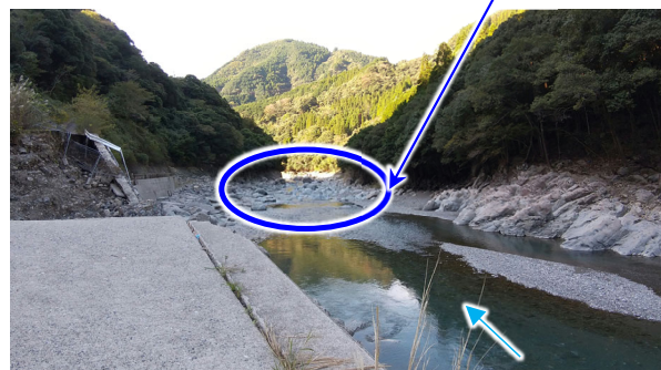
流水型ダムサイトの下流に位置する早瀬 (河床部放流設備敷高のコントロールポイント)
