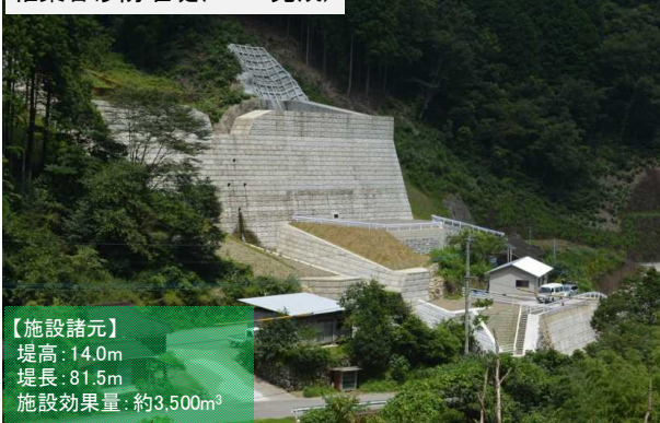
椎葉谷砂防堰堤(H27.7完成)
