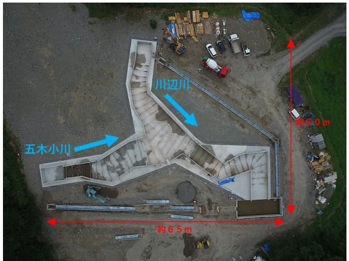
河川の形状を正確に再現するための横断板の設置が完了しました。
