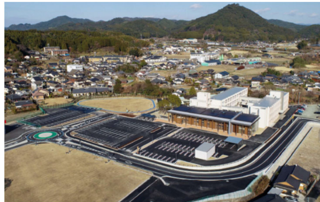
南関町役場及び防災広場（南関町）
