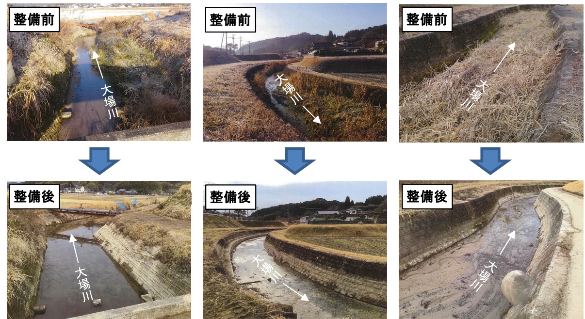
大場川の掘削状況(令和4年度実施)
