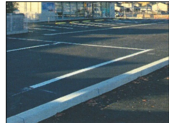
駐車場内の透水性舗装施工例
