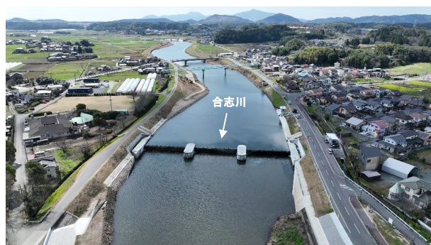
完成した山城堰(合志川)
