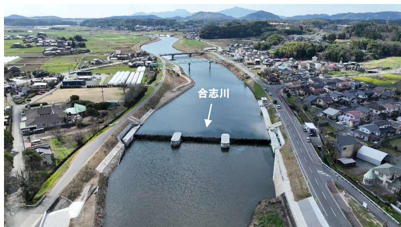
完成した山城堰（合志川）
