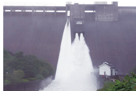
放水時の放流状況
