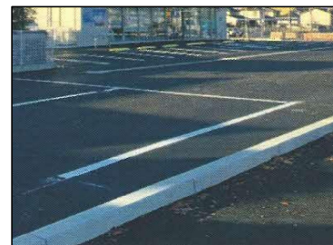
駐車場内の透水性舗装施工例
