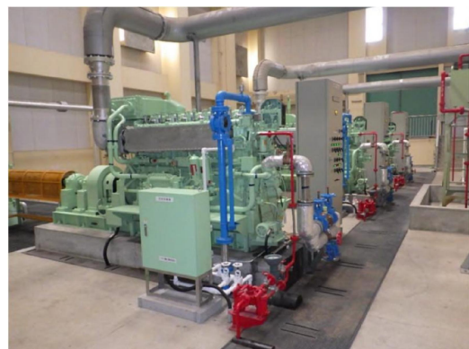
ポンプ本体・原動機・減速機等2基の更新
