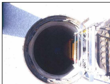
1,000㎡以上の開発行為に対する新設道路内、雨水浸透枳の設置例
