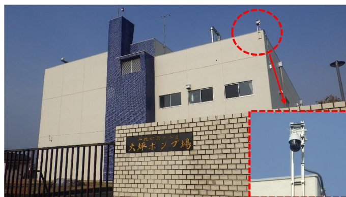
監視カメラ設置状況
