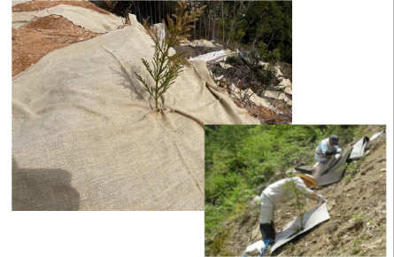
生分解性防草シートの実証施工(イメージ)
