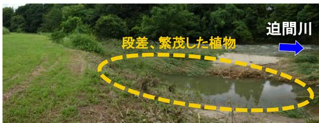
写真①：高水敷と川までの間に段差があり、植物も繁茂しているため、川に安全に近づくことができない。
