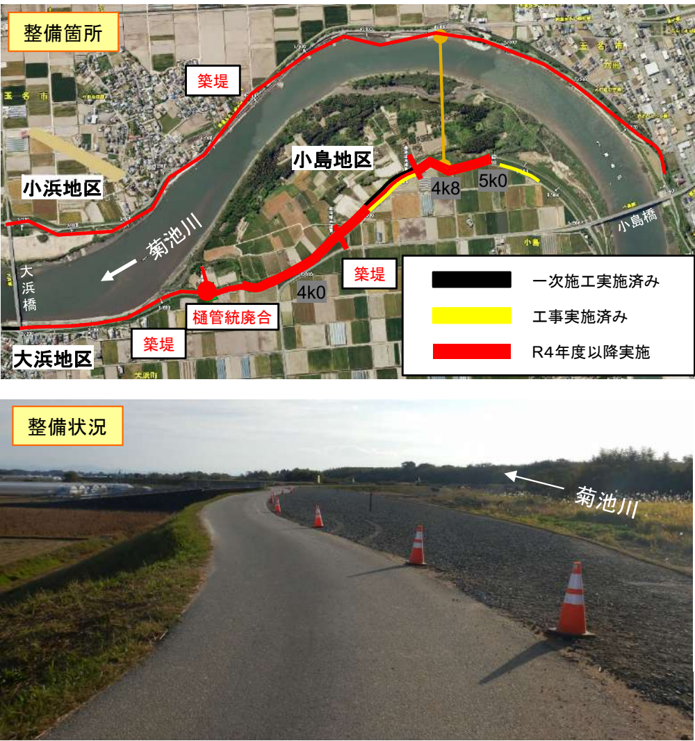
小島地区:築堤(整備中)
