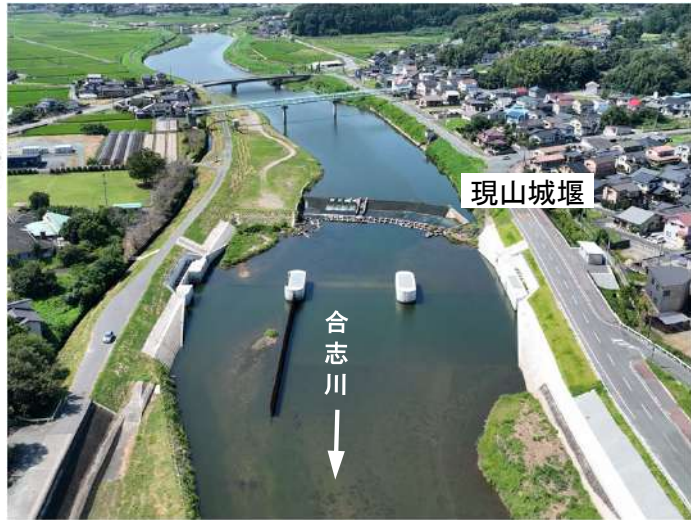
山城堰改築(整備中)
