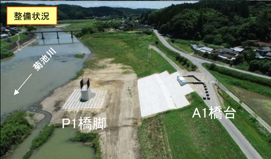
菰田橋架替（整備中）
