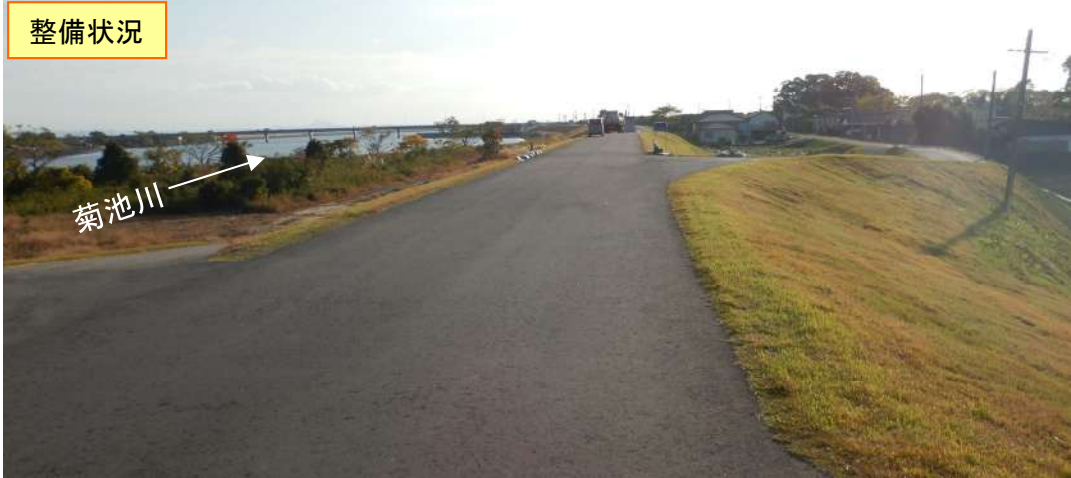
小浜地区:築堤(整備後)
