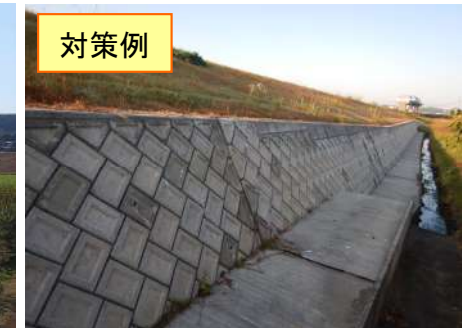
菰入地区の堤防浸透対策
