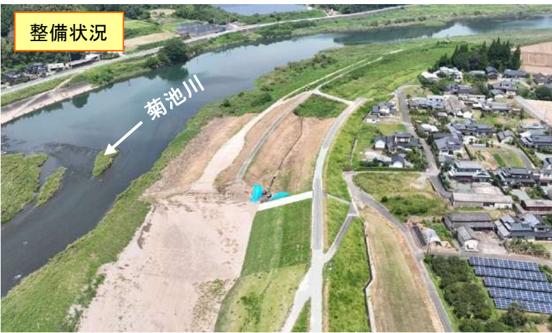
小原地区:旧堤撤去(整備中)
