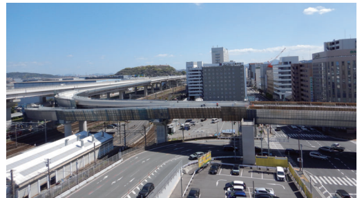
黒崎西ランプの施工状況（小倉方面を望む）
