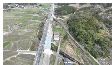
呉川に架かる橋梁の施工状況 (行橋方面を望む)
