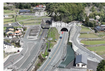
閉鎖トンネルの現況 (行橋方面を望む)
