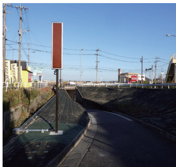
冠水対策（情報板） （国道10号 小倉南区）
