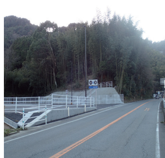
チェーン着脱場整備 （国道201号 飯塚市）
