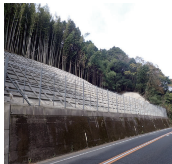
法面对策 （国道201号 飯塚市）
