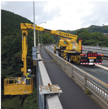
橋梁点検車による点検
