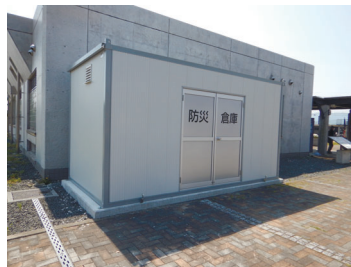
防災機能強化 (備蓄倉庫) (道の駅「しんよしとみ」)
