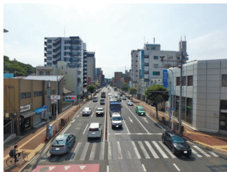
整備後【無電柱化完了】
