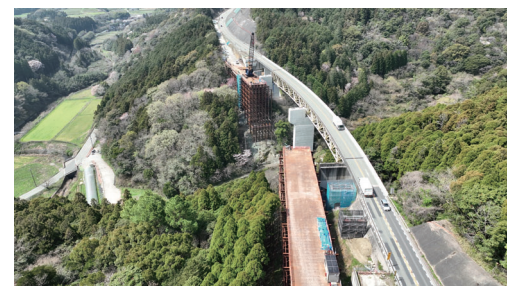
福ヶ谷橋施工状況（福岡方面を望む）
