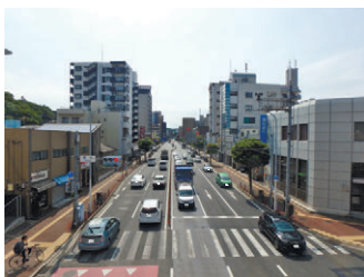
整備後【無電柱化完了】
