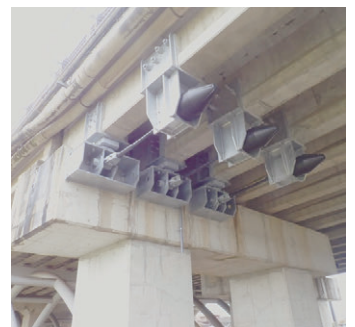
耐震補強（落橋防止） （国道201号 東大橋）
