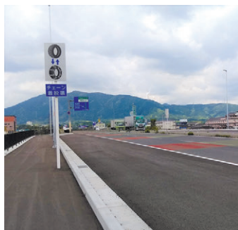
チェーン着脱場整備 （国道201号 BP 飯塚市）
