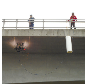
ドローンによる点検
