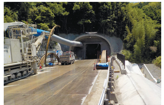
岡垣トンネルの施工状況
