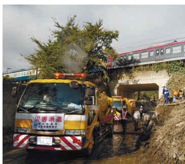
TEC-FORCE隊の派遣② 令和元年10月 台風19号 （長野県長野市）
