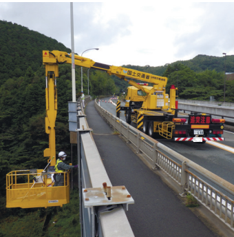
橋梁点検車による点検
