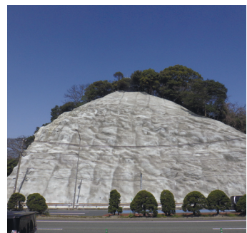
法面对策 （国道3号 水巻町）
