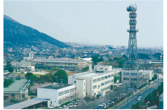
北九州国道事務所 庁舎
