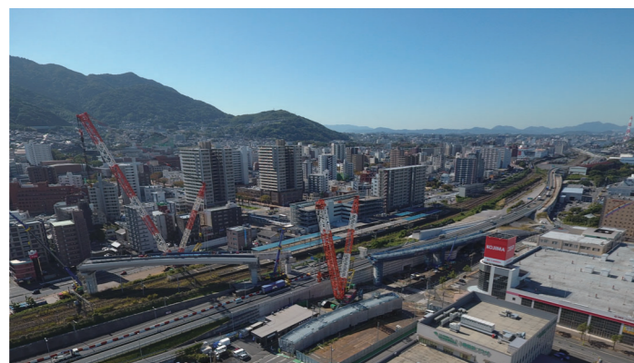
国内最大級クレーンによるJR跨線部の架設 (R1.11)
