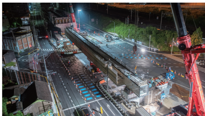
国道3号西本町一丁目交差点部の夜間架設 (R3.5)
