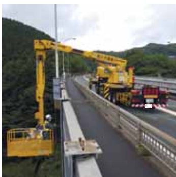
橋梁点検車による点検
