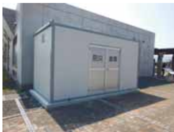
防災機能強化（備蓄倉庫） （道の駅「しんよしとみ」）
