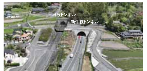
既設トンネルの現況（行橋方面を望む）
