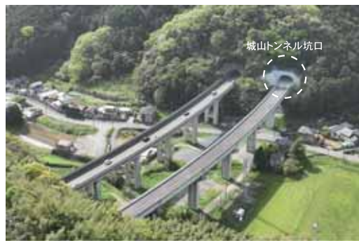
城山トンネル付近の施工状況（福岡方面を望む）
