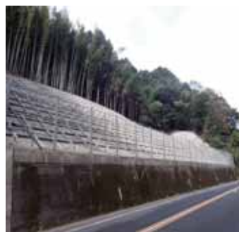
法面対策 （国道201号 飯塚市）
