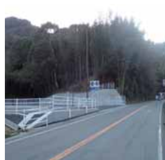
チェーン着脱場整備 （国道201号 飯塚市）
