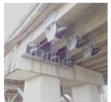
耐震補強（落橋防止装置） （国道201号 東大橋）
