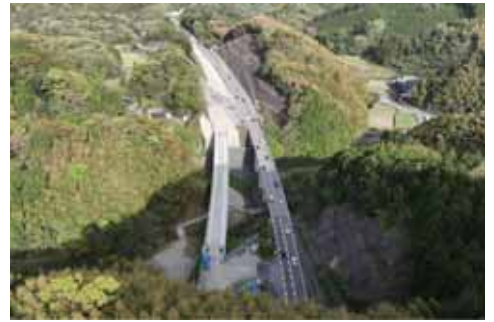
筑穂IC付近の施工状況（田川方面を望む）
