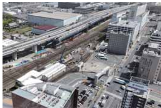
黒崎西ランプの施工状況（小倉方面を望む）
