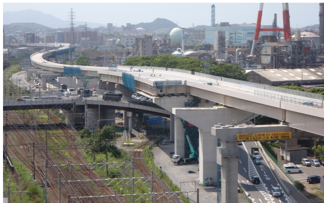
黒崎高架橋 上部工・床版工 工事状況
