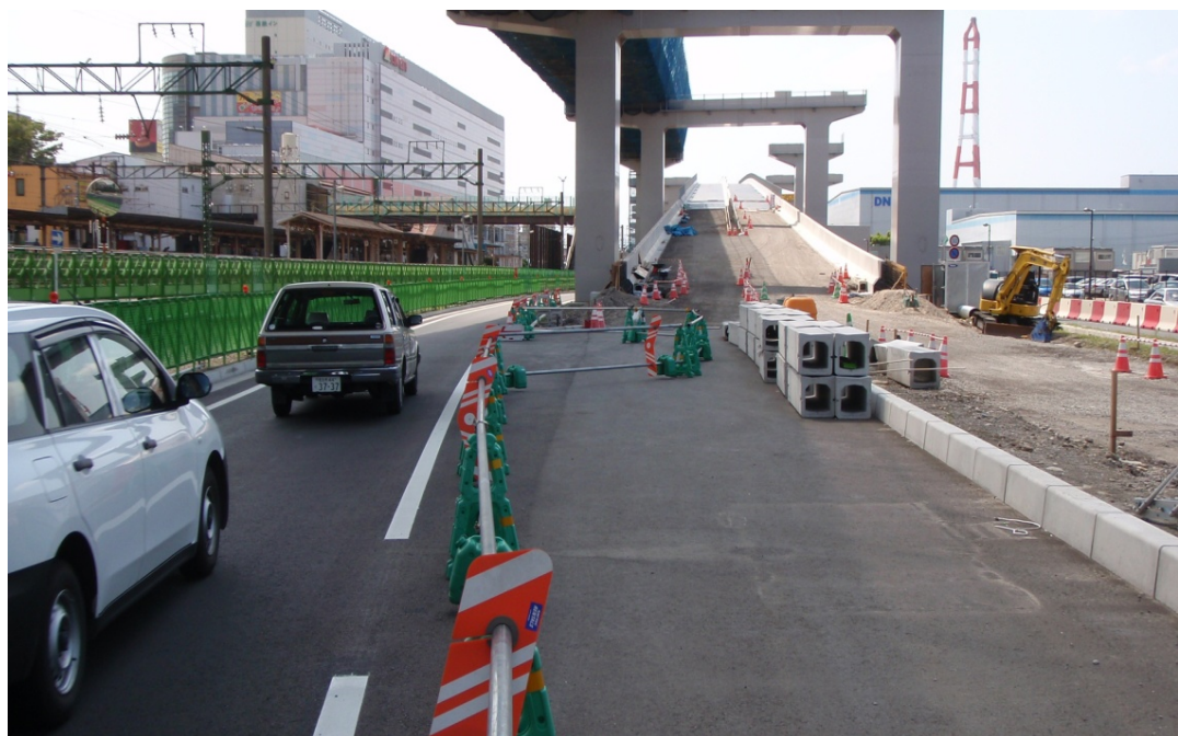
黒崎北ランプ 工事状況
