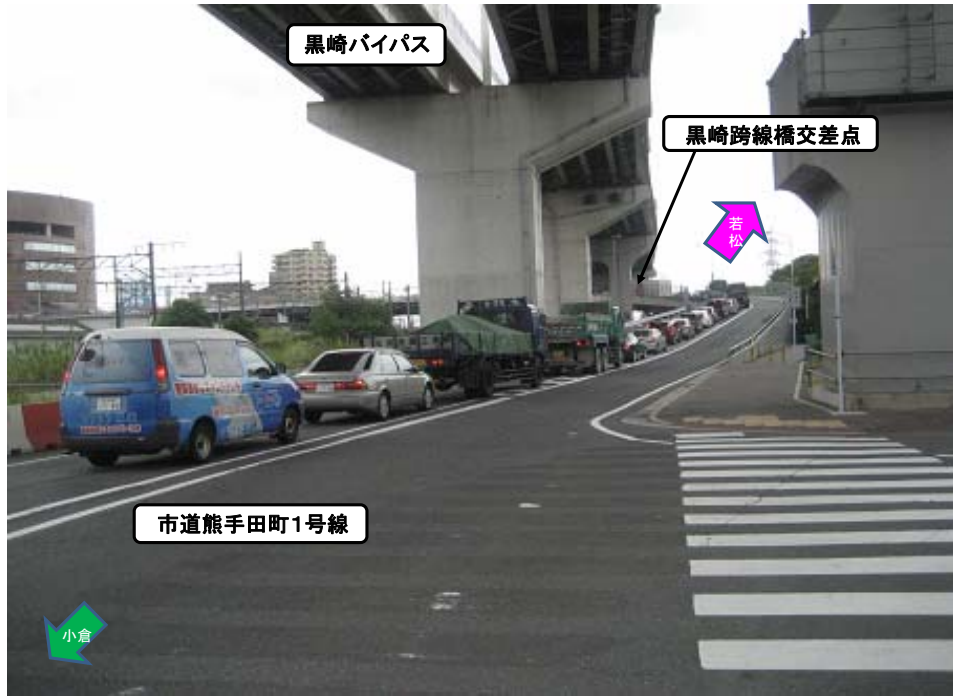
①小倉側より黒崎跨線橋交差点側を撮影
