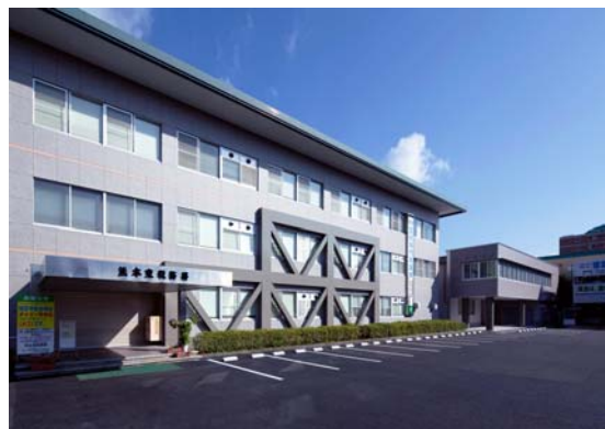
■耐震改修の事例 (熊本東税務署2009年度完成)
