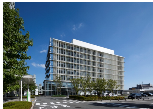
熊本合同庁舎B棟
