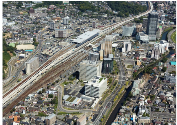
■熊本地方合同庁舎（2014年度完成）
