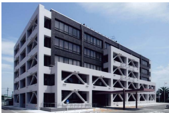
大分合同庁舎(耐震改修) (2009年度)
