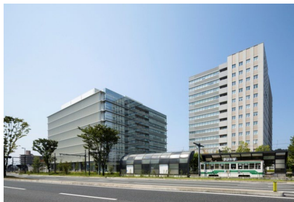
熊本地方合同庁舎B棟 (2014年度完成)
