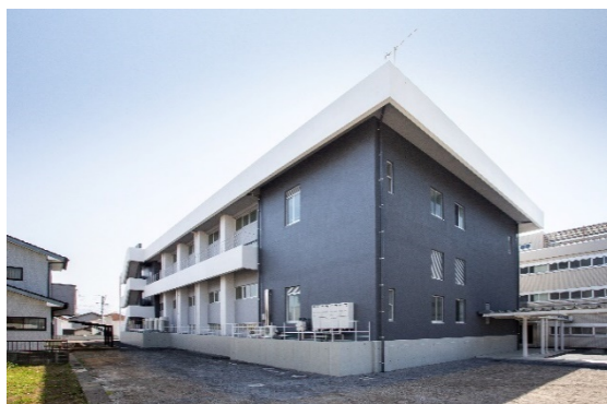
熊本県警察学校（武道場） (2019年度完成)
