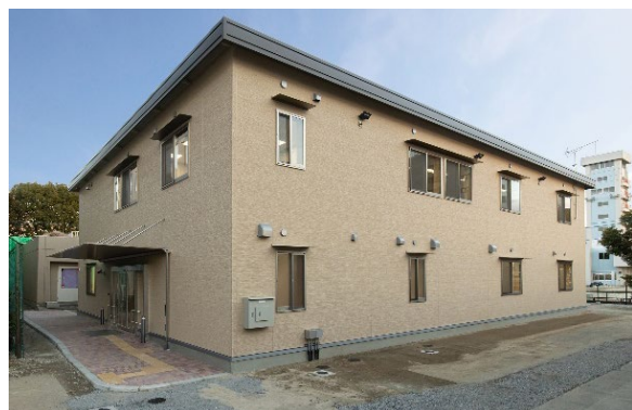
土地改良技術事務所 (2020年度完成)
