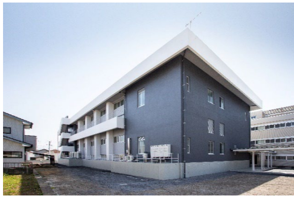
熊本県警察学校(武道場) (2019年度完成)
