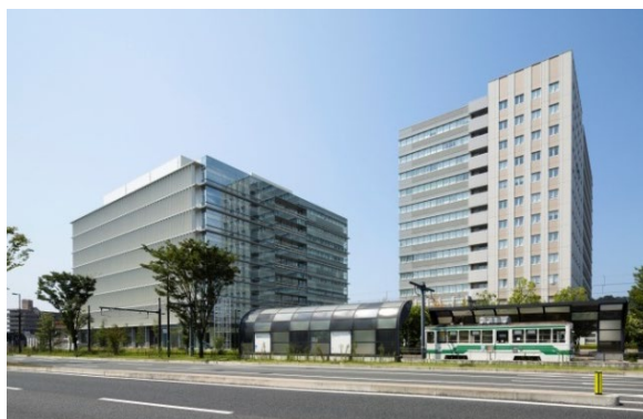
熊本地方合同庁舎B棟 (2014年度完成)
