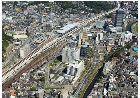
■ 熊本地方合同庁舎（2014年度完成）
