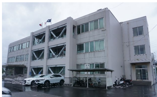
■耐震改修の事例 (大分港湾合同庁舎 2025年度完成)
