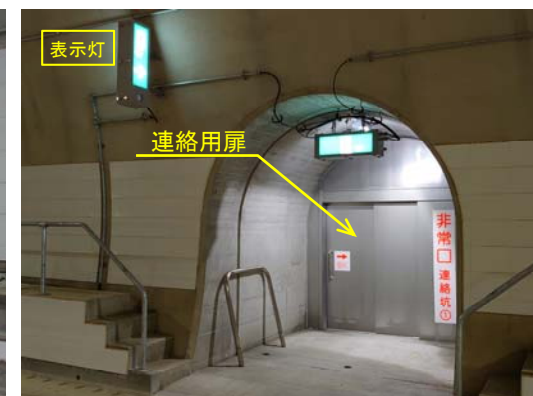
非常口 (避難連絡坑)
