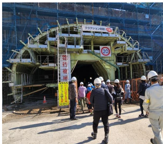
滝室坂トンネル
