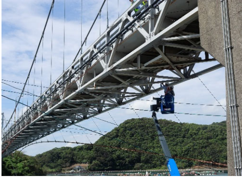
【高所作業車を用いた点検状況】
