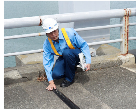
【伸縮装置の点検状況】
