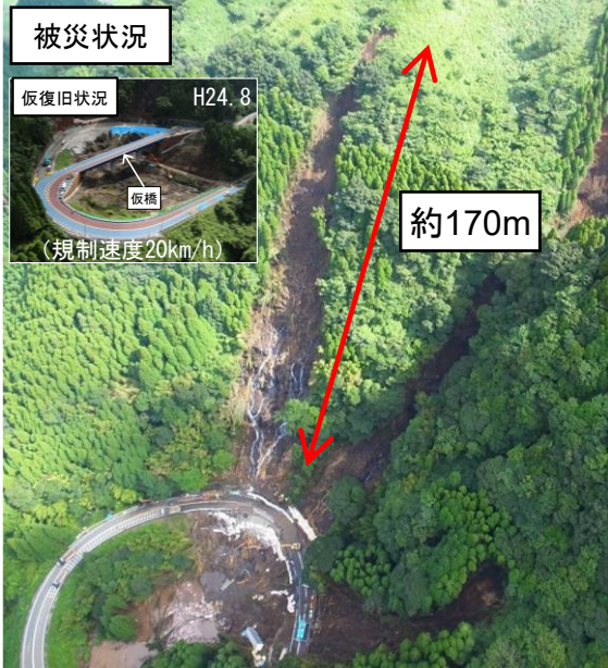
▲ 被災状況 (H24. 7) と仮復旧状況 (H24. 8)
