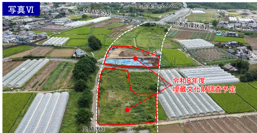
埋蔵文化財調査の状況
