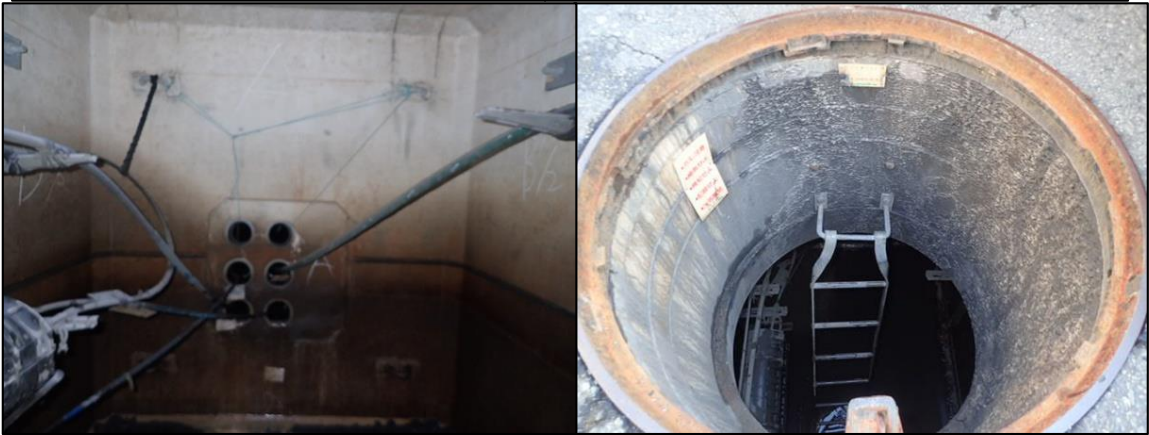
点検実施状況
