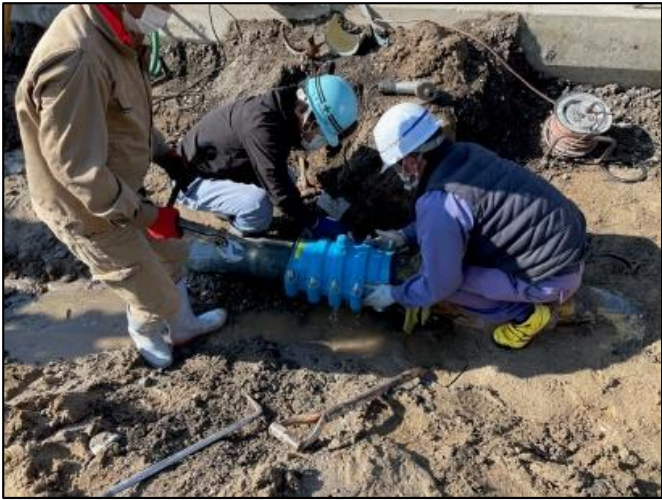
補修状況 主要地方道水俣田浦線 （水俣市）
