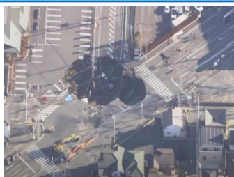
1月31日時点の事故現場の状況
