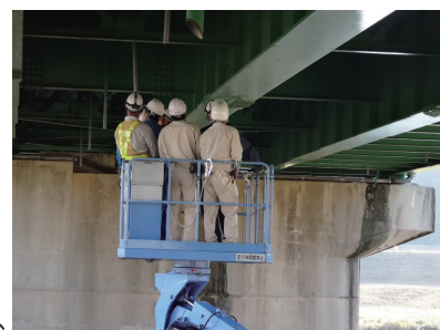
自治体が管理する橋梁の点検
