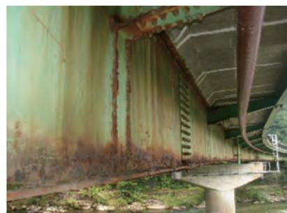
鋼材の腐食に伴う強度の低下
