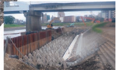
護岸補強整備状況
