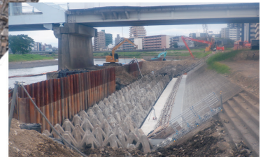
護岸補強整備状況
