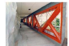
鉄骨ブレースによる壁の補強
