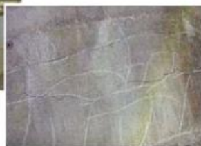
下部工のひび割れ
