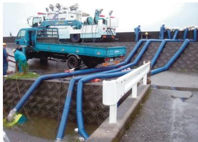
洪水のおそれがある場合は内水被害対策のための排水機場を稼働させるとともに、水防活動に対する情報収集支援や排水ポンプ車の派遣などを行い、洪水による被害を最小限に防ぎます。
