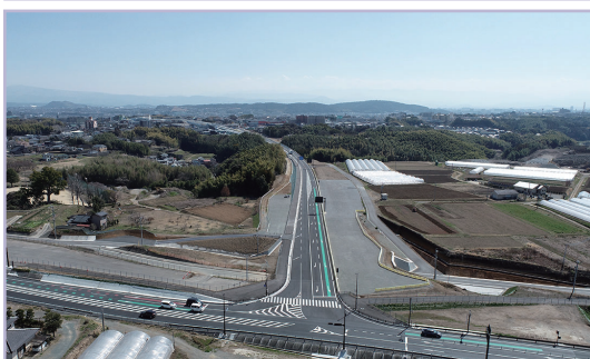
3-2工区開通後の様子(令和5年3月)
