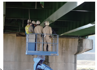
自治体が管理する橋梁の点検
