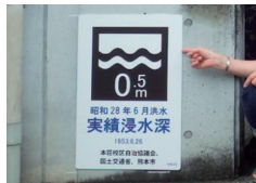
熊本市本荘地区では、S28.6.26洪水実績浸水深の洪水標識を設置
